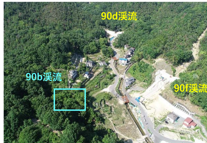
【砂防堰堤全景 (90b,90d,90f溪流)】
