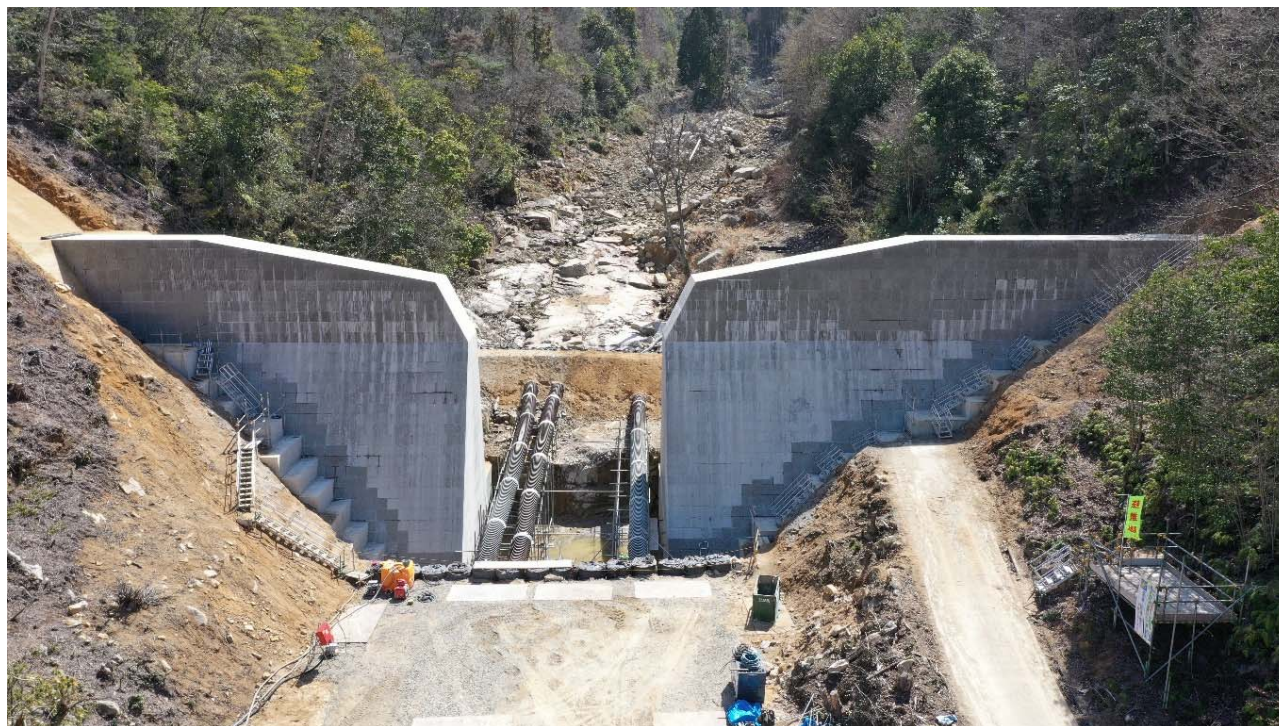
【大谷川3号砂防堰堤 施工状況 (堰堤本体)】
