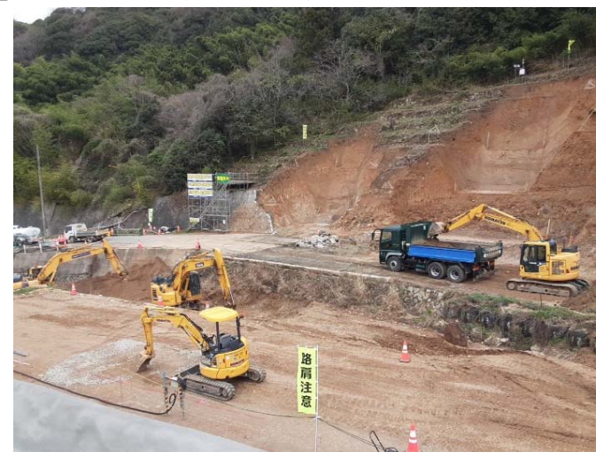
【砂防堰堤本体の掘削状況】
