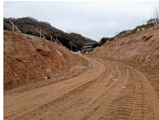
【工事用道路範囲の土砂掘削状況】
