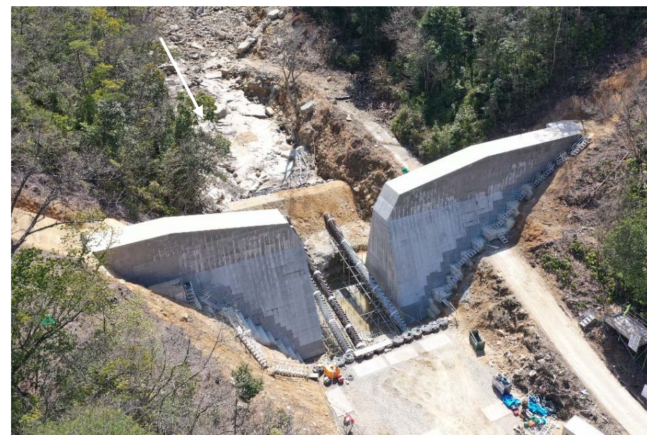
【大谷川3号砂防堰堤 施工状況 (堰堤本体)】
