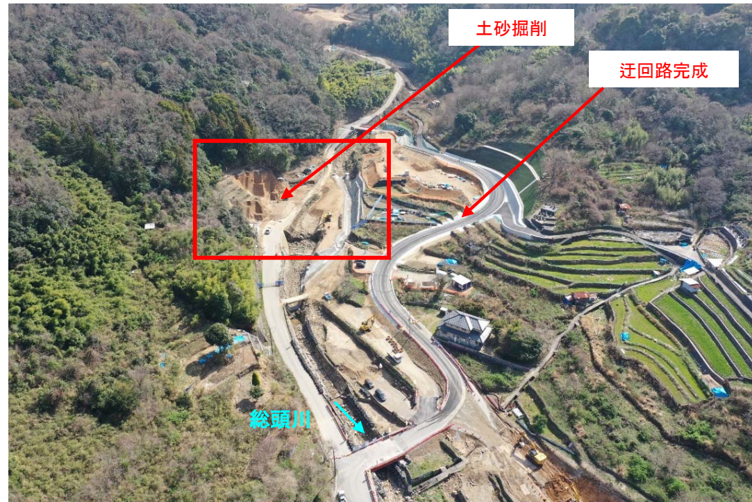
【施工状況（下流から上流を望む）（R5. 3月末時点）】
