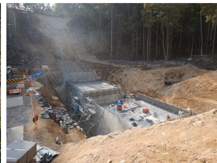
【コンクリート打設状況】
