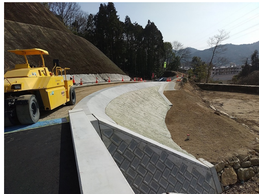
【管理用道路 施工状況 (盛土工)】
