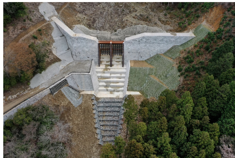
【上原1号砂防堰堤 (完成)】
