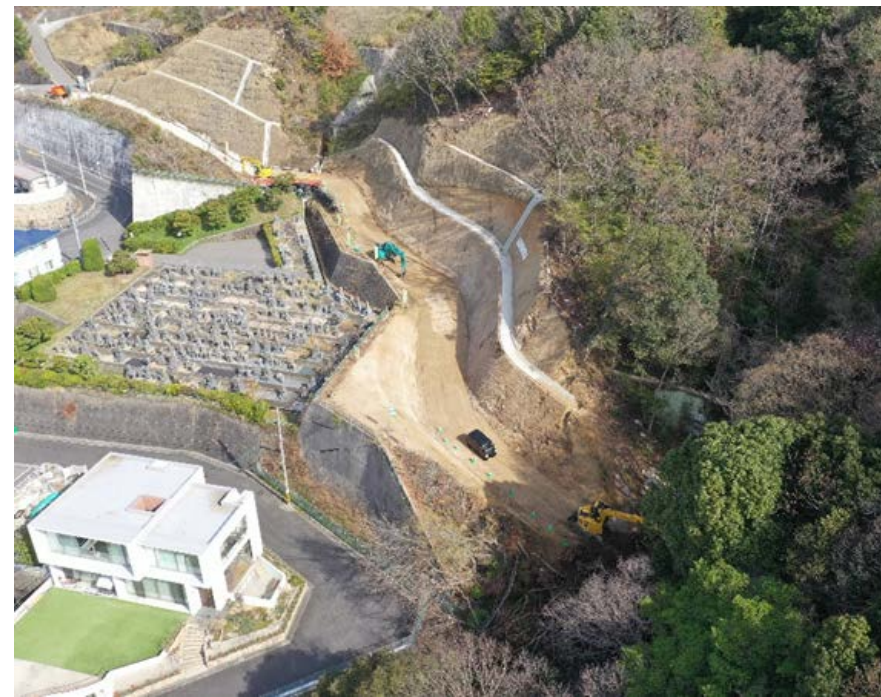
【 施工箇所状況】
