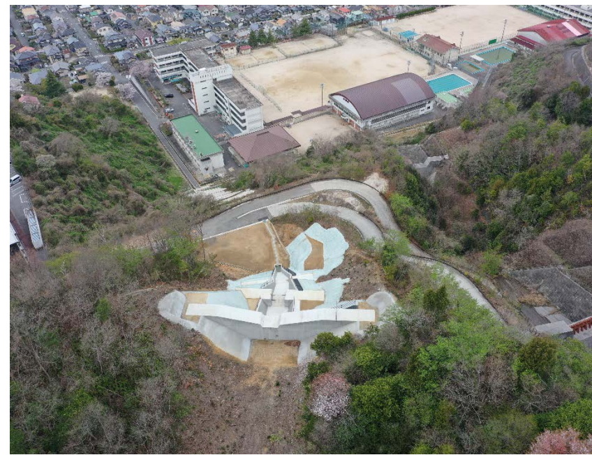
【砂防堰堤 施工箇所(上流側より)】
