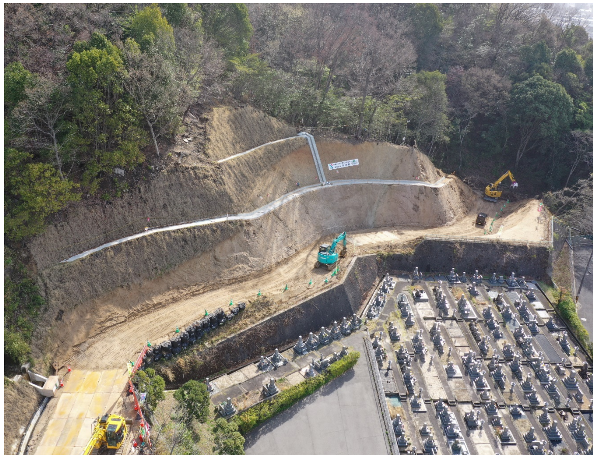
【全 景 (起点側より)】
