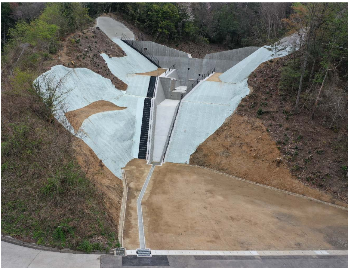
【五月が丘8号砂防堰堤 施工状況】
