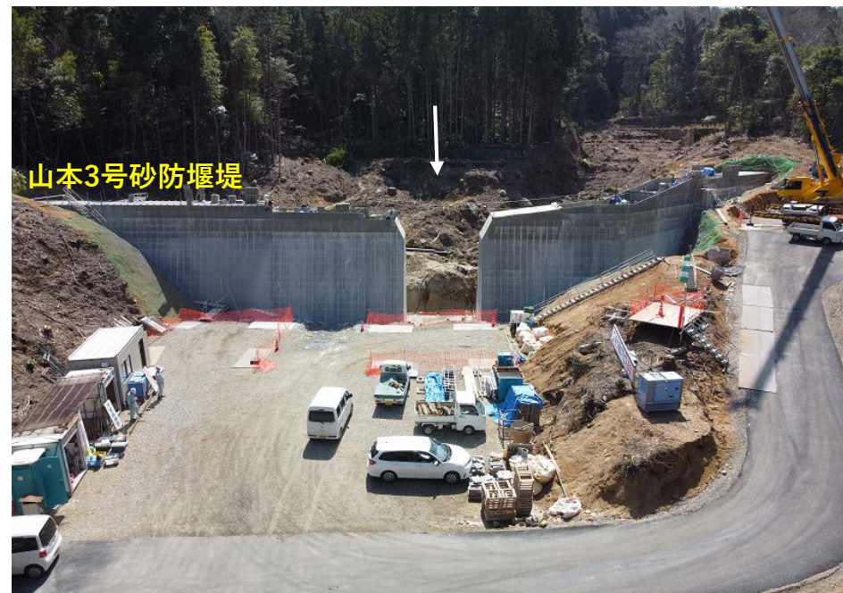
【施工状況 (砂防堰堤)】
