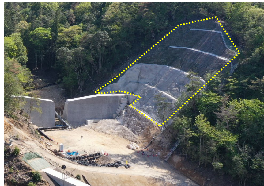
【大谷川 2号砂防堰堤 施工状況 (法面)】
