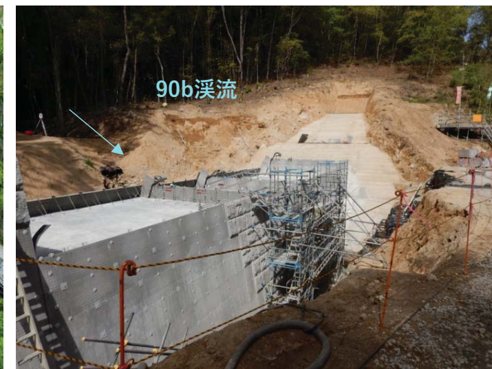
【コンクリート打設状況】
