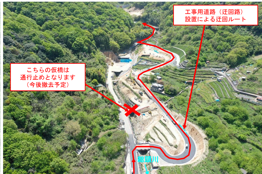
【施工状況（下流から上流を望む）（R5. 4月末時点）】
