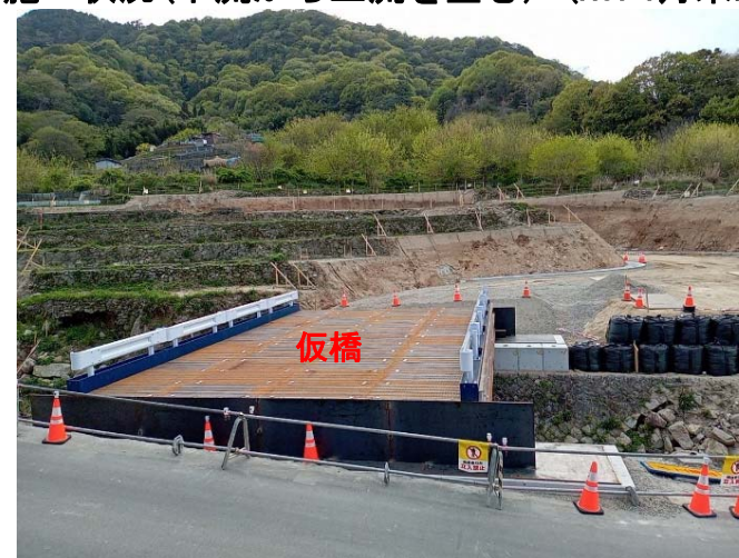
【仮橋の設置状況】
