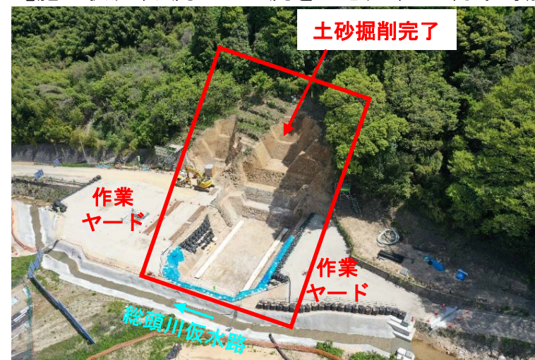
【砂防堰堤箇所の状況】
