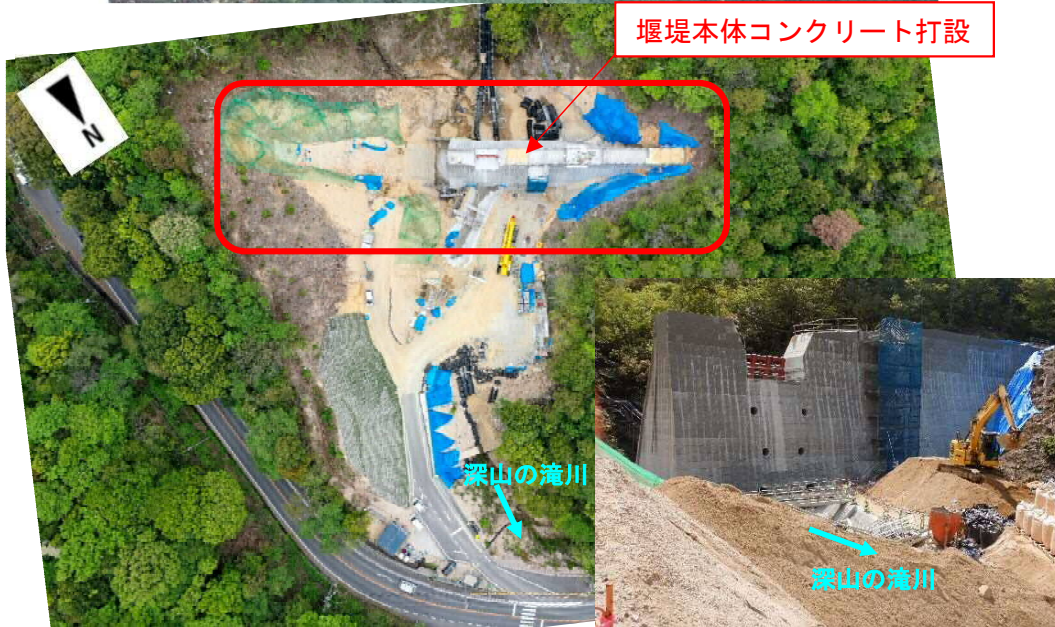
【深山の滝川溪流下流の施工状況】
