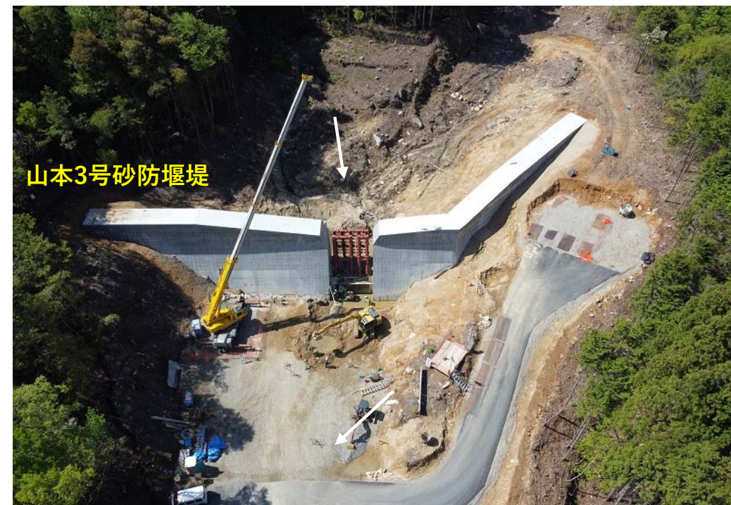
【施工状況（堰堤下流流路）】
