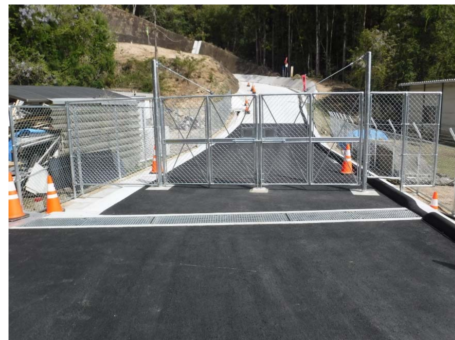
【管理用道路 施工状況 (入口)】
