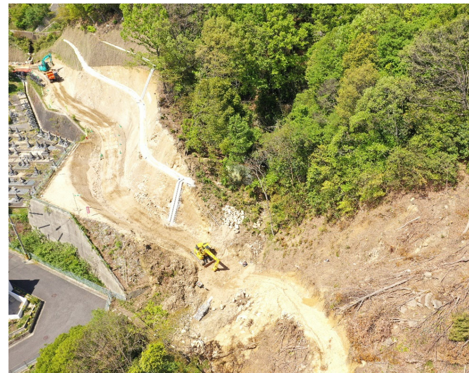
【 施工箇所状況】
