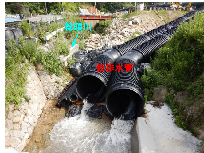
【仮排水管の設置状況】
