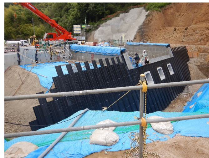
【砂防ソイルセメント（INSEM工法）の施工状況】
