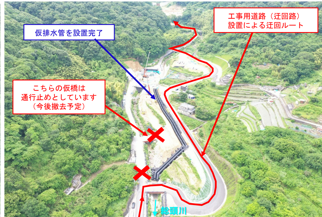
【施工状況（下流から上流を望む）（R5. 6月末時点）】
