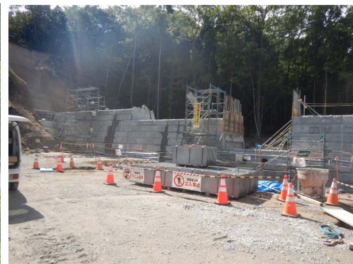
【コンクリート打設状況】
