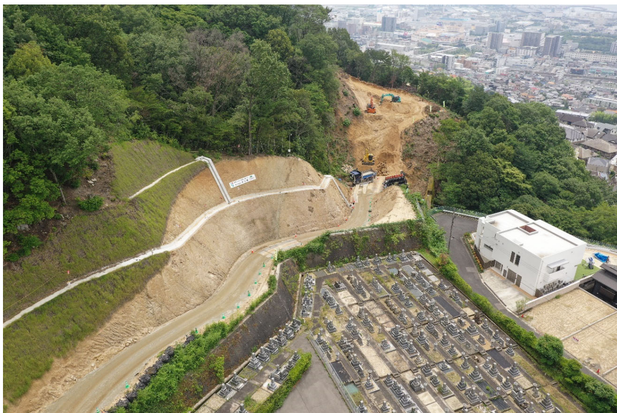
【全 景 (起点側より)】
