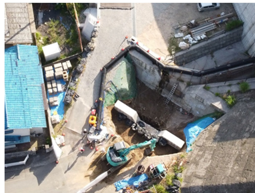
【 施工状況（垂直壁） 】
