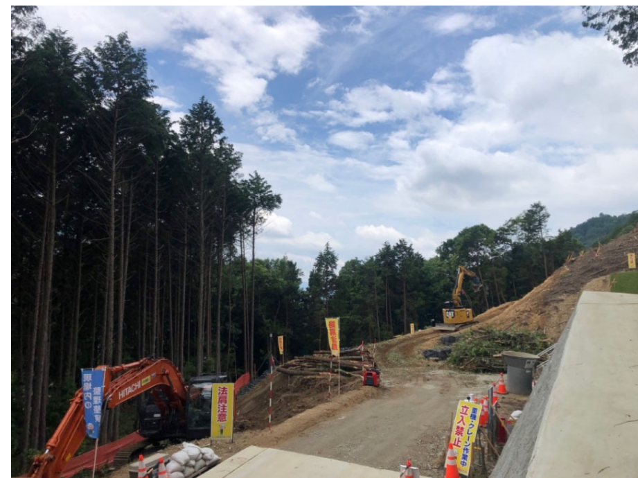
【既設管理用道路部より2号堰堤側】
