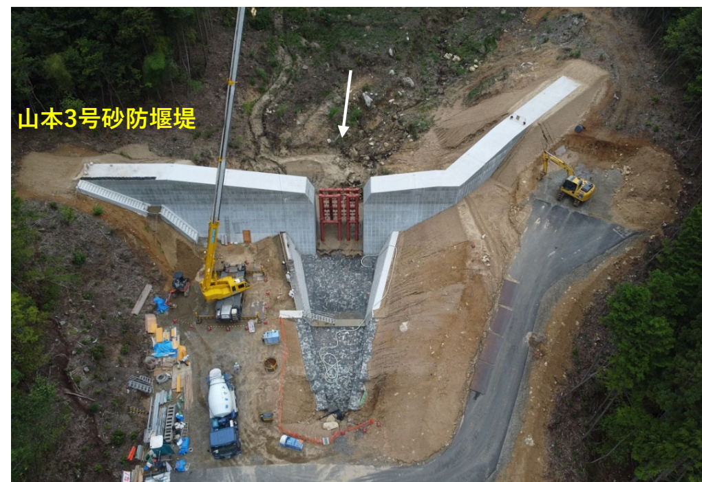
【施工状況（堰堤下流流路及び法面工等）】
