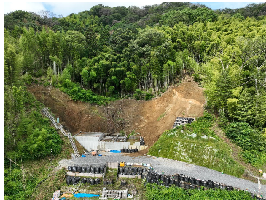
【施工状況（下流側より）】
