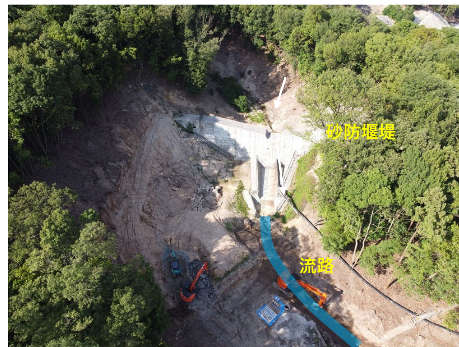
【砂防堰堤付近】
