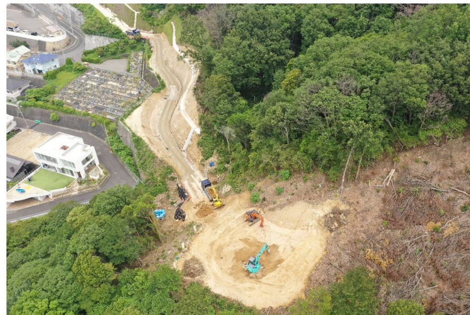
【 施工箇所状況】
