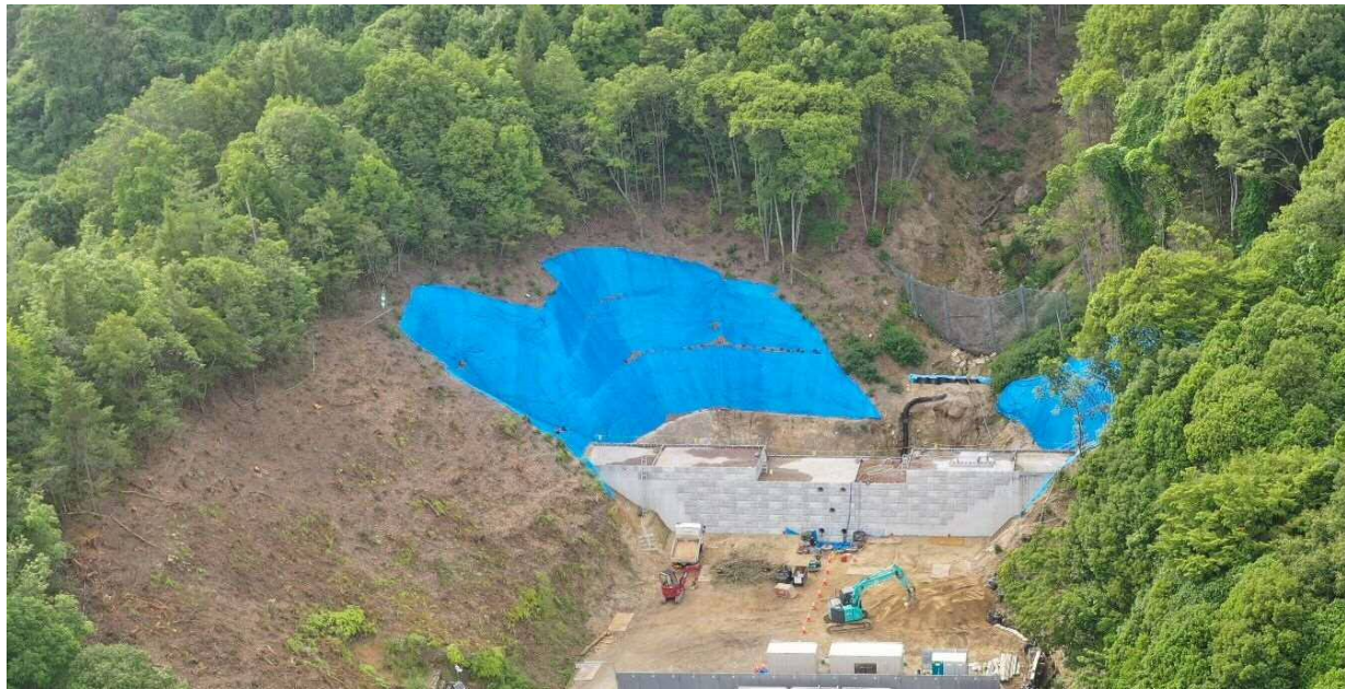
【施工状況（下流側より）】
