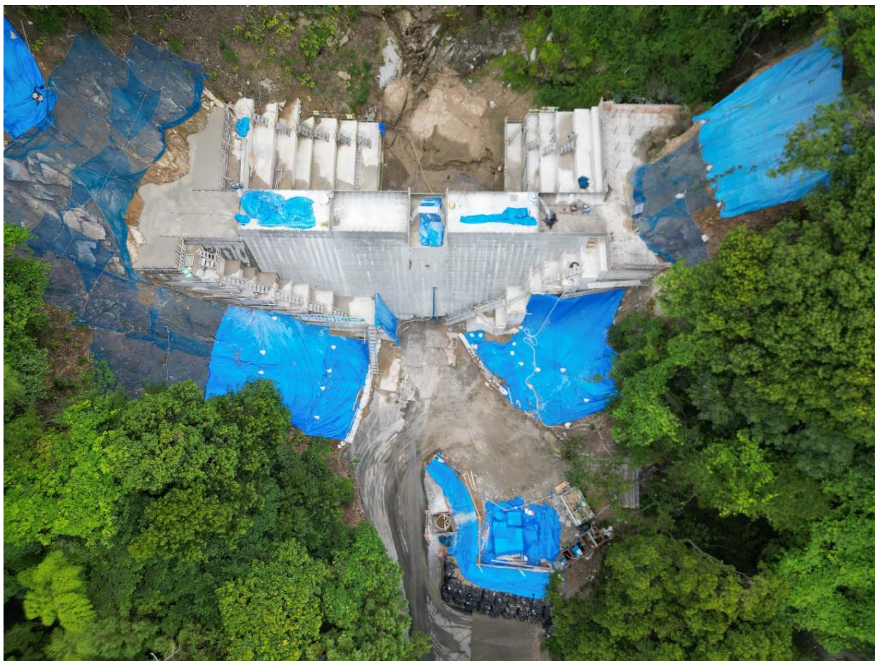
【施工状況（上空より）】
