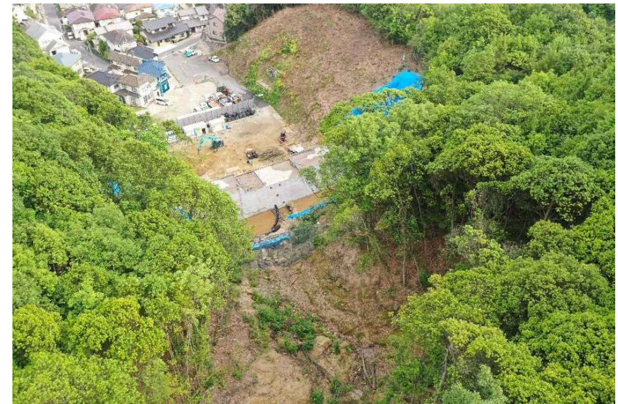
【施工状況（上流側より）】
