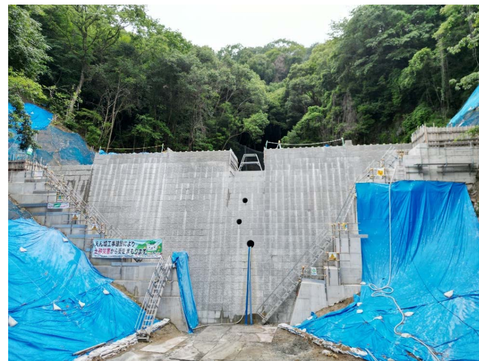
【施工箇所（下流側より）】
