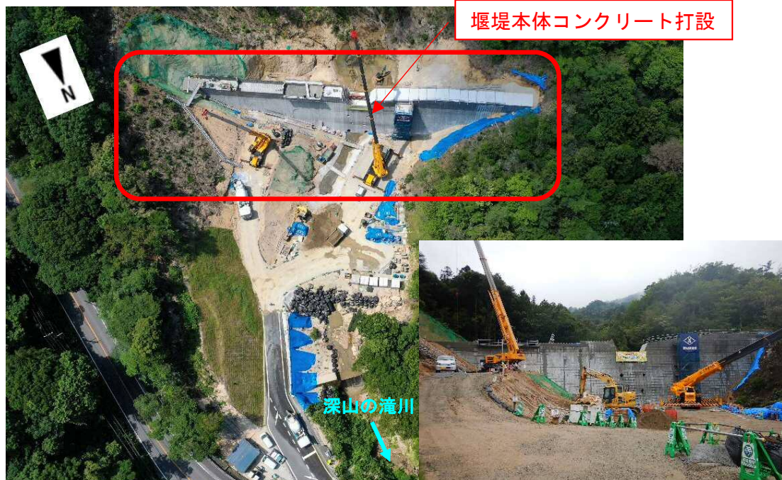
【深山の滝川溪流下流の施工状況】
