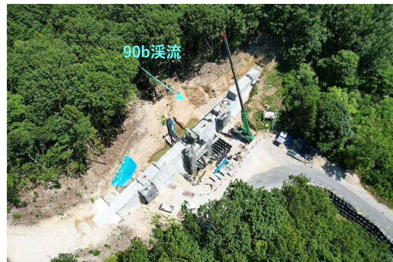
【堰堤整備箇所上空より】
