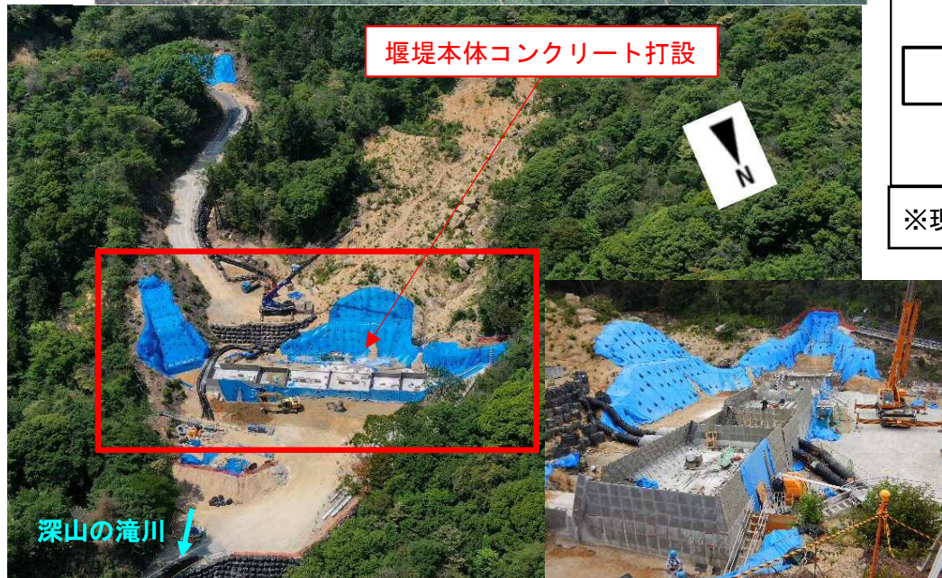
【深山の滝川溪流上流の施工状況】
