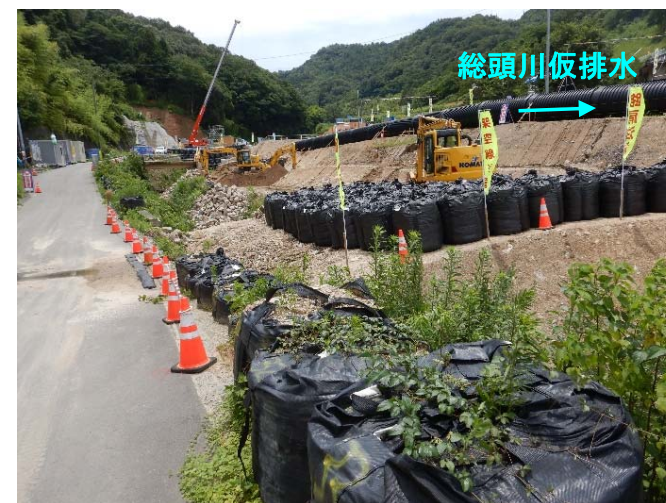
【総頭川河道内の施工状況】
