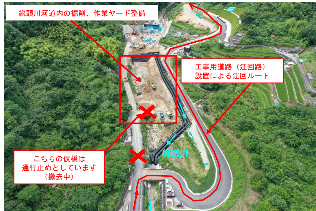
【施工状況（下流から上流を望む）（R5. 7月末時点）】
