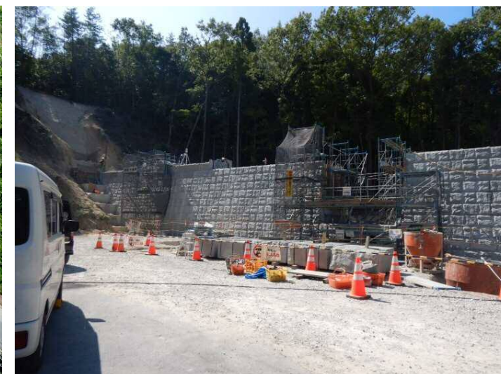
【コンクリート打設状況】
