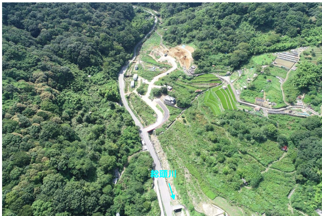
【総頭川遊砂地施工状況（着手前R4. 8月末時点）】
