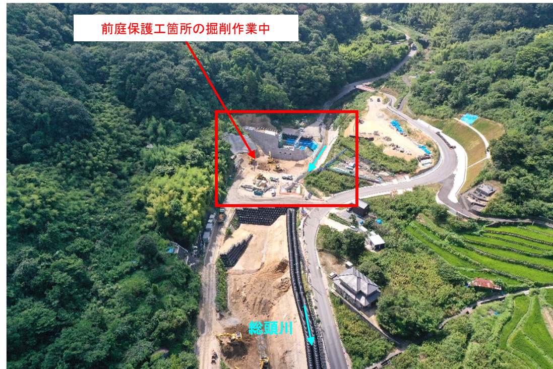
【施工状況（下流から上流を望む）（R5. 8月末時点）】
