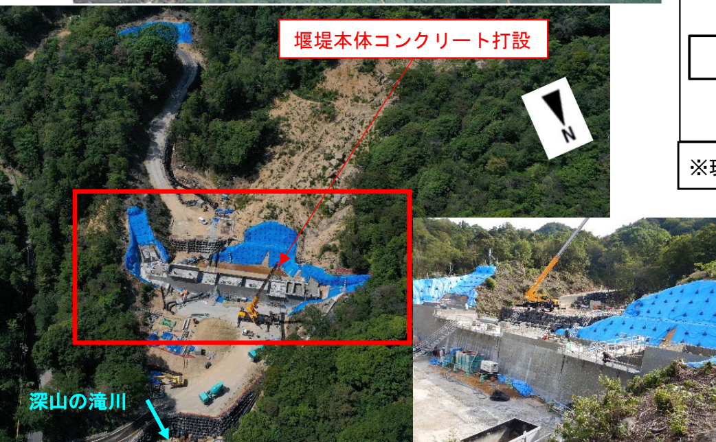
【深山の滝川溪流上流の施工状況】
