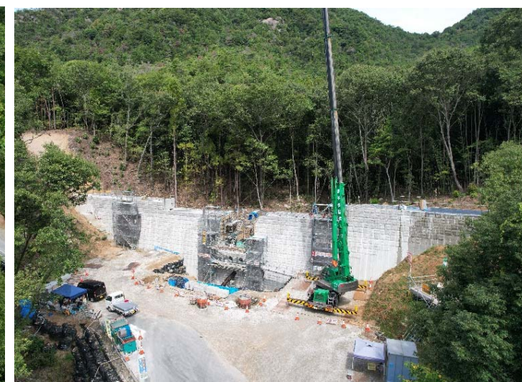
【コンクリート打設状況】
