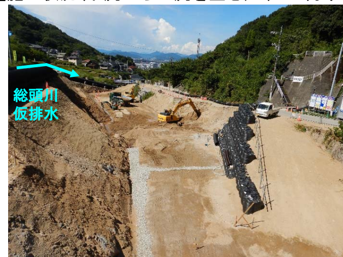
【総頭川河道内の施工状況（上流から下流を望む）】
