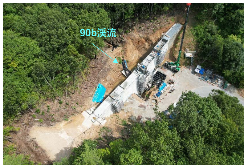
【堰堤整備箇所上空より】
