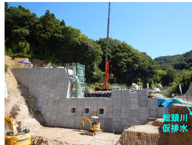
【砂防堰堤施工状況（本堤正面を望む）】
