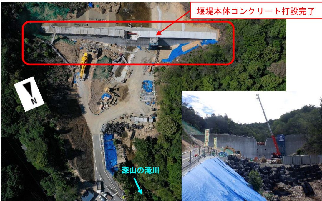
【深山の滝川溪流下流の施工状況】
