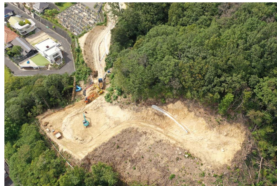
【 施工箇所状況】
