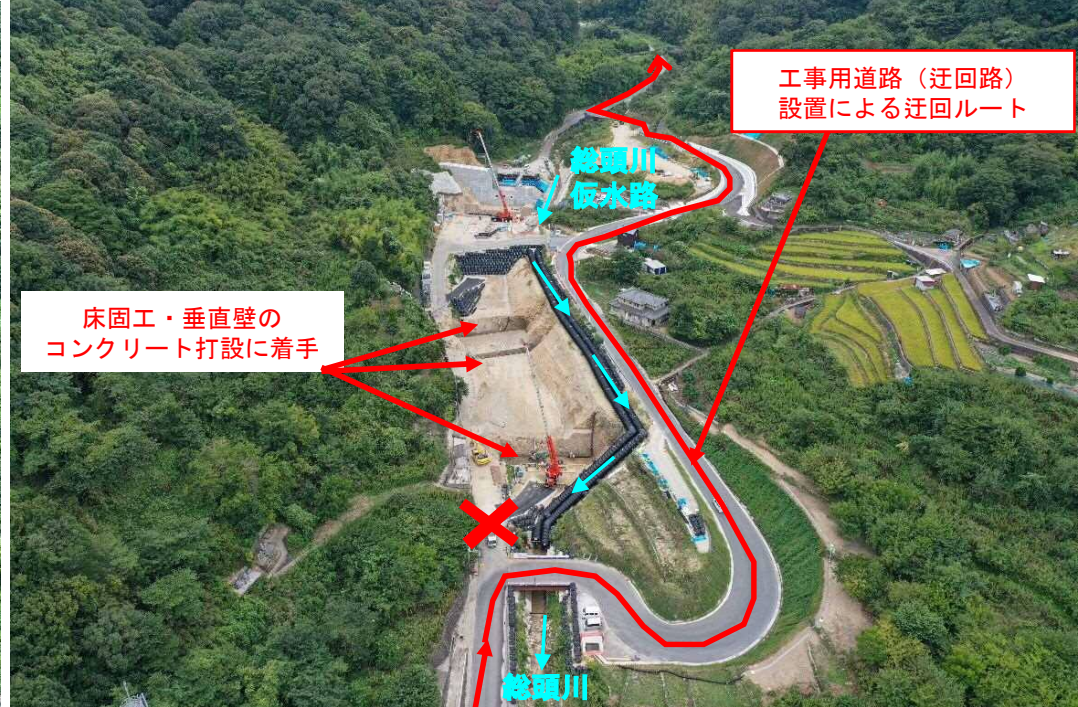
【施工状況（下流から上流を望む）（R5. 9月末時点）】
