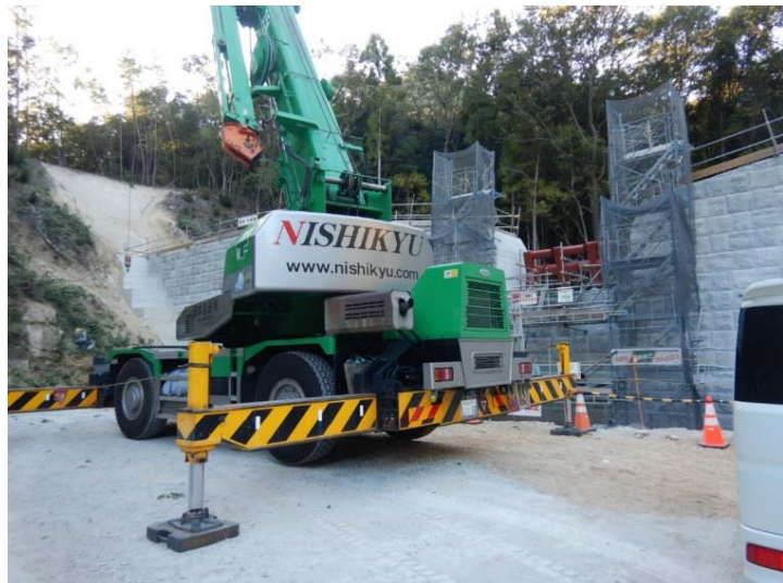
【鋼製スリット設置状況】
