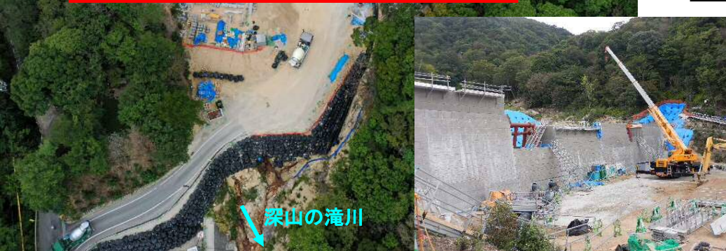
【深山の滝川溪流上流の施工状況】
