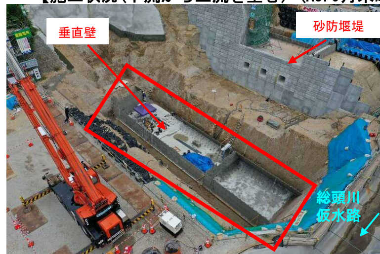
【前庭保護工施工状況（上空から望む）】
