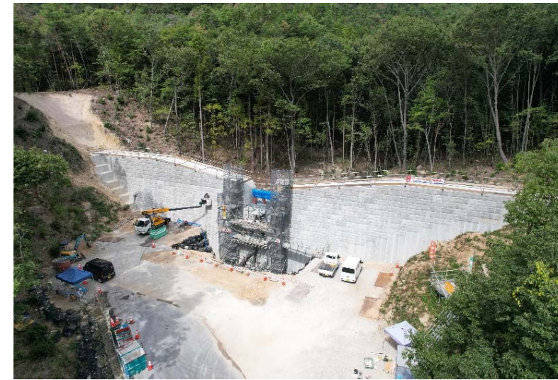
【鋼製スリット設置状況】
