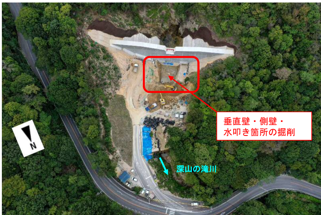
【深山の滝川溪流下流の施工状況】
