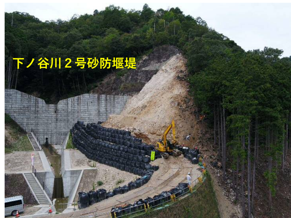
【管理用道路（下流）箇所】
