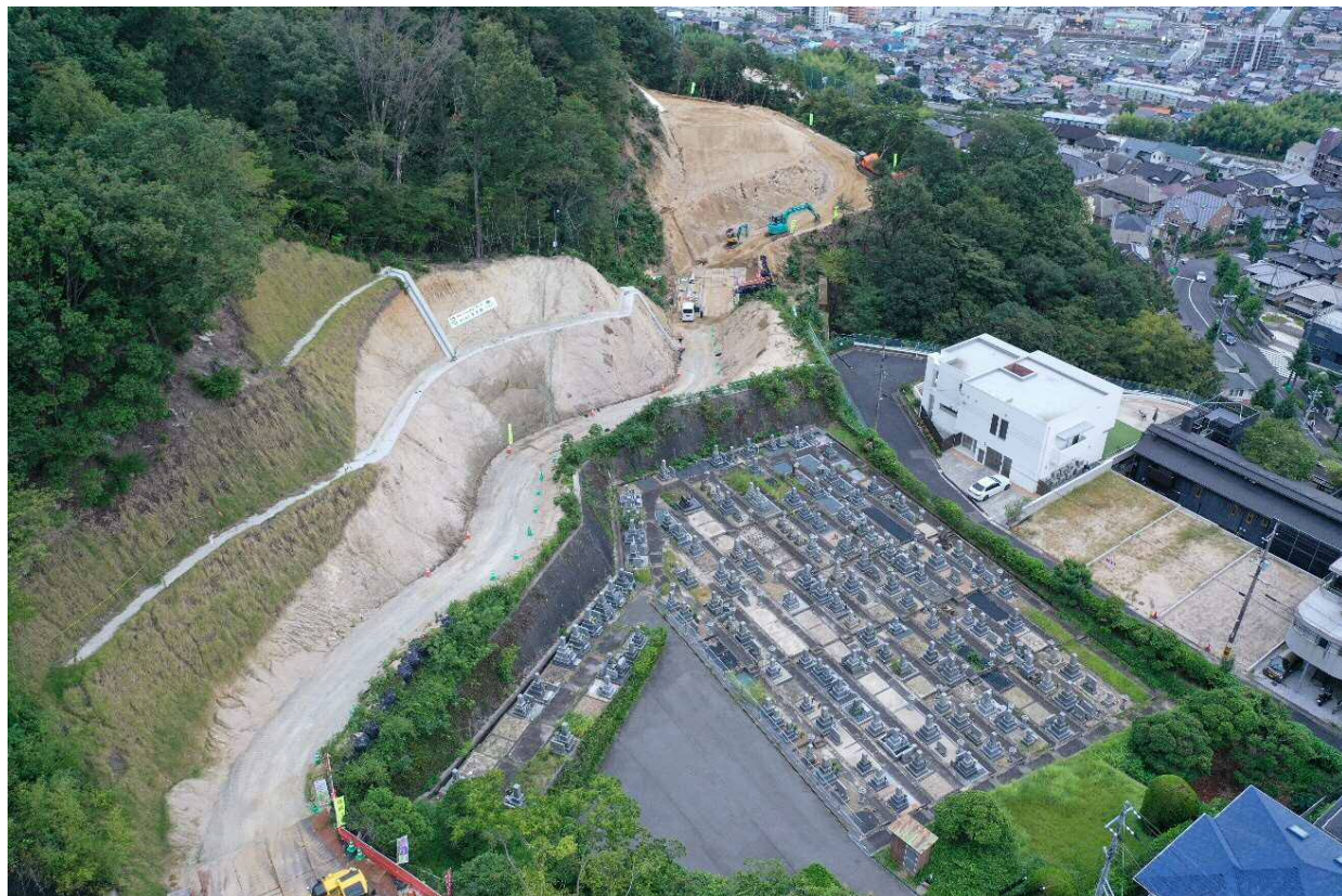
【全 景 (起点側より)】
