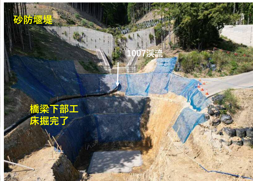
【管理用道路（橋梁）の施工状況】
