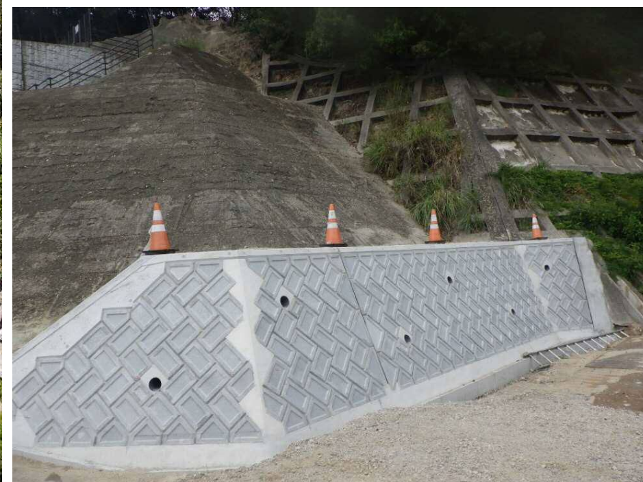
【 施工状況 (流路 : ブロック積) 】
