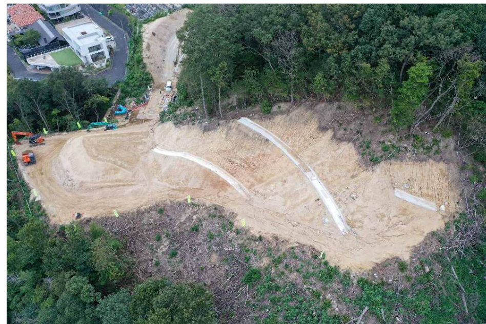
【 施工箇所状況】
