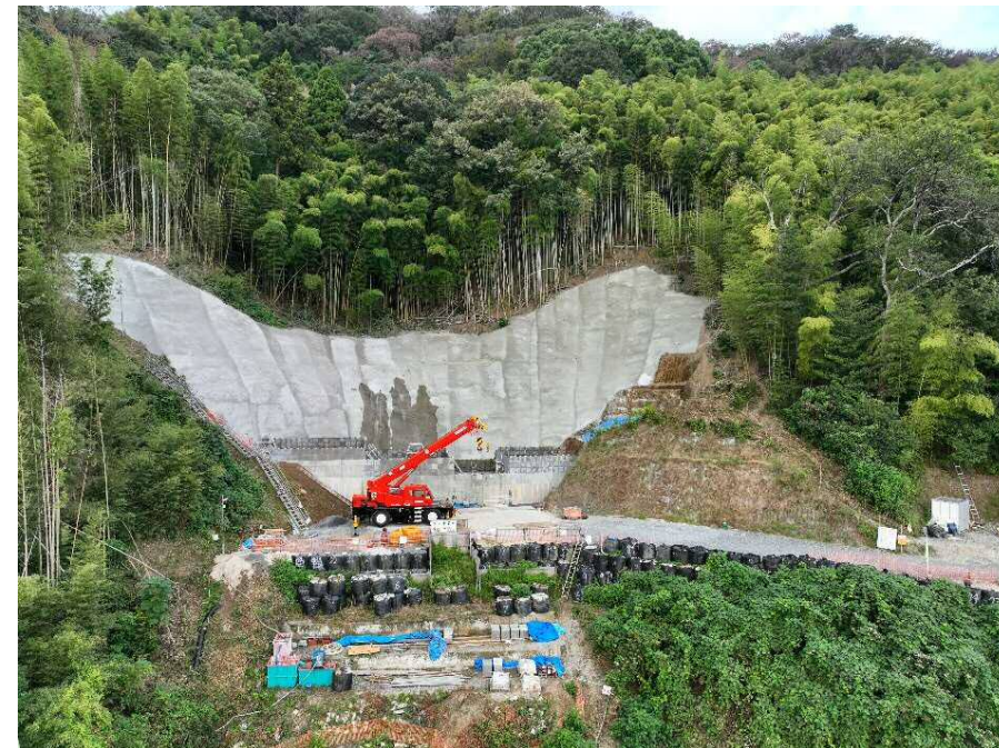
【施工状況（下流側より）】
