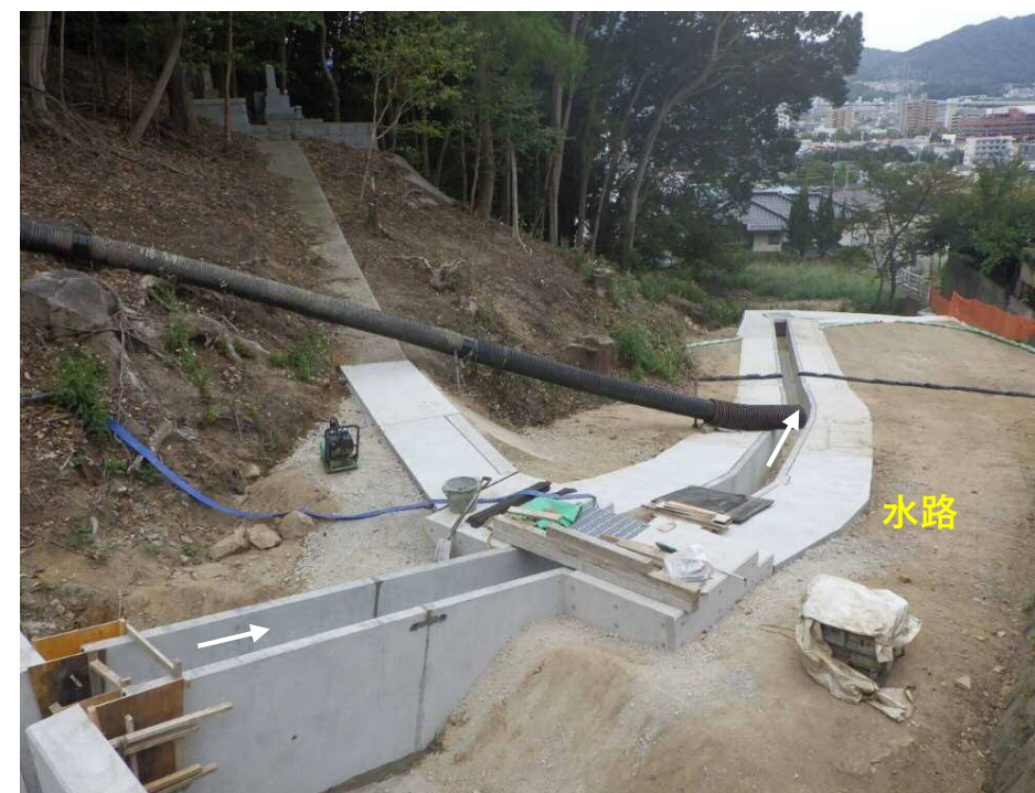
【水路 施工状況】
