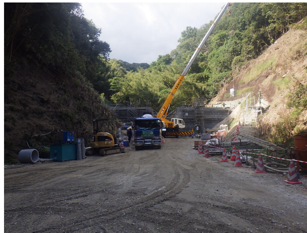
【砂防堰堤工施工状況】
