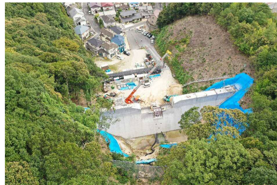
【施工状況（上流側より）】
