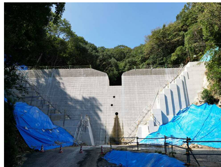
【施工箇所（下流側より）】
