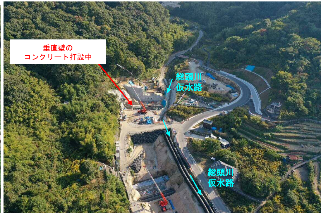
【施工状況（下流から上流を望む）（R5. 10月末時点）】
