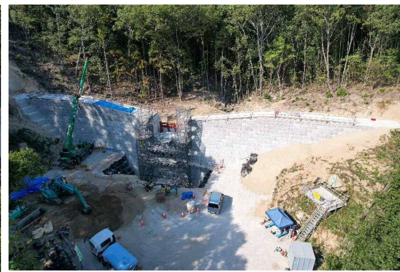
【砂防堰堤本体の埋め戻し状況】
