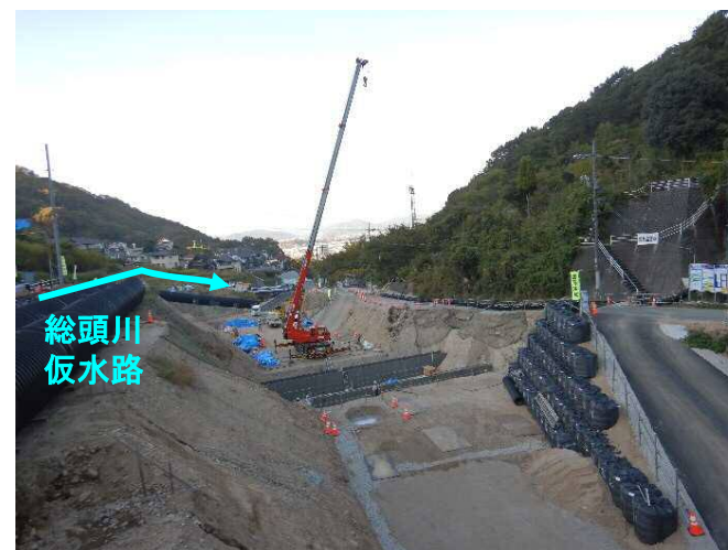
【遊砂地内の状況（上流から下流を望む）】
