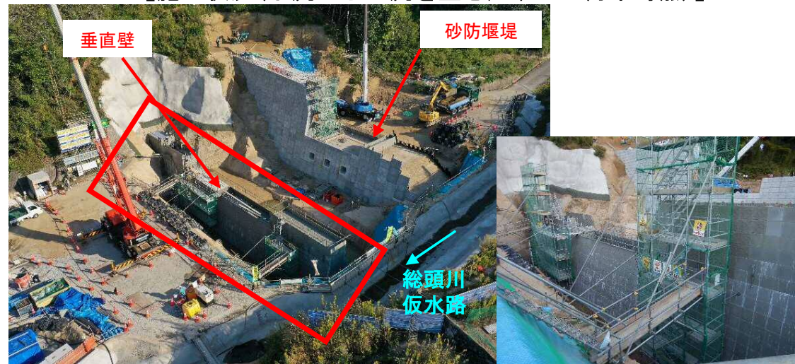
【垂直壁施工状況（上空から望む）】
