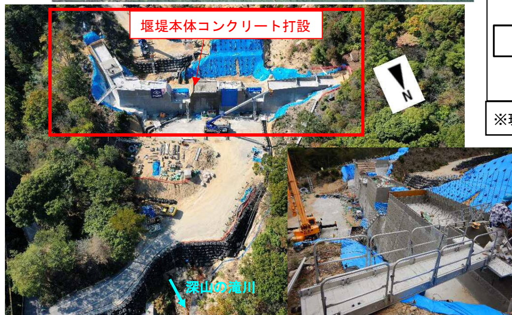
【深山の滝川溪流上流の施工状況】
