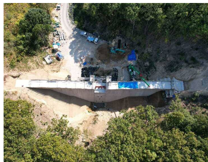
【砂防堰堤本体の埋め戻し状況】
