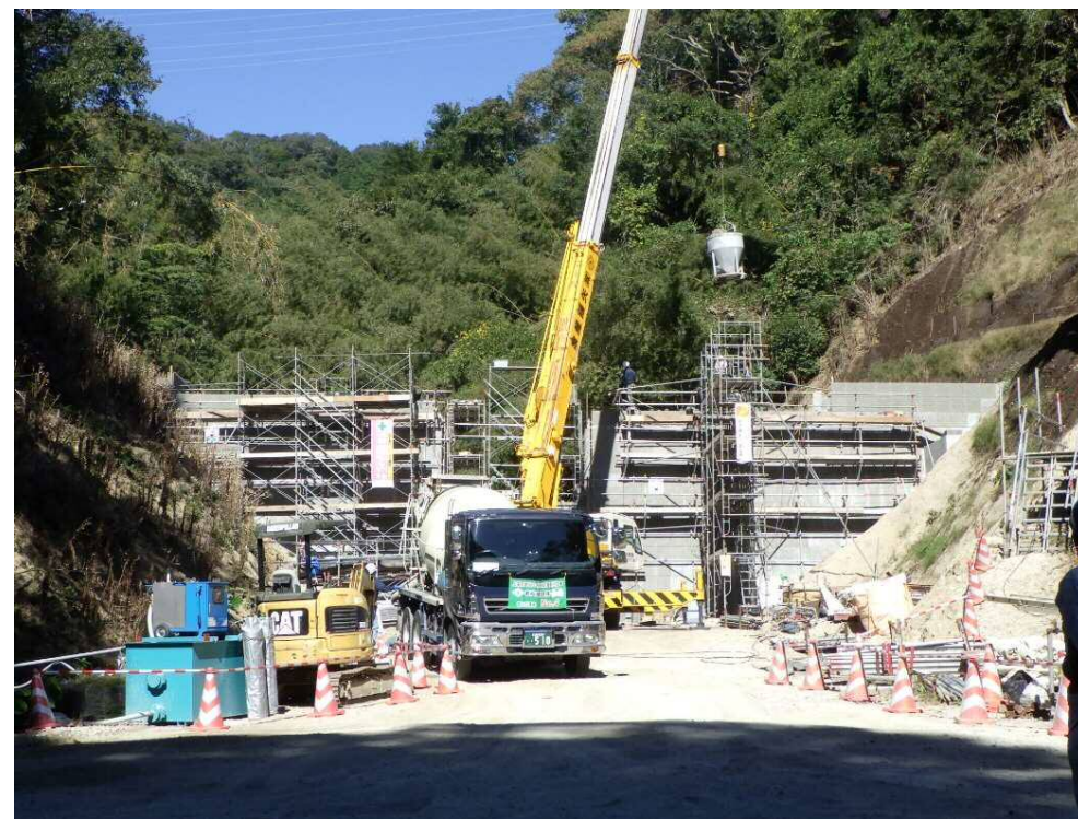
【砂防堰堤工施工状況】
