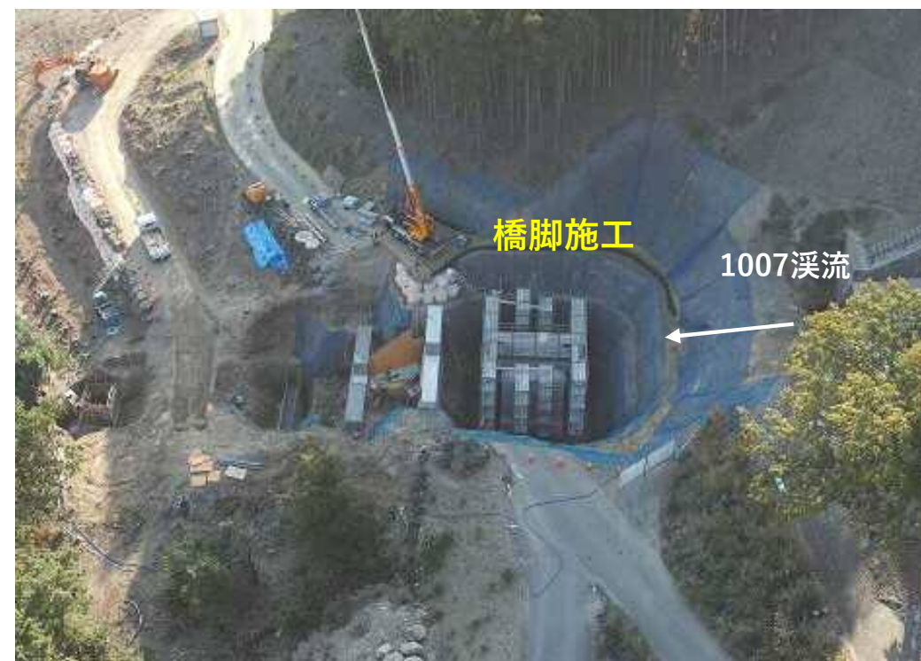
【管理用道路（橋梁）の施工状況】
