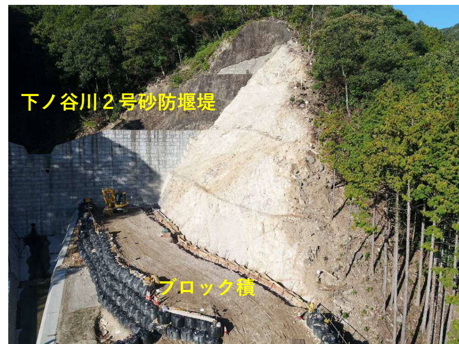
【管理用道路（下流）箇所】
