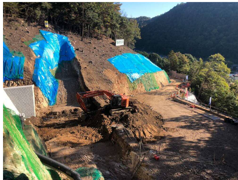
【砂防堰堤箇所の掘削状況】
