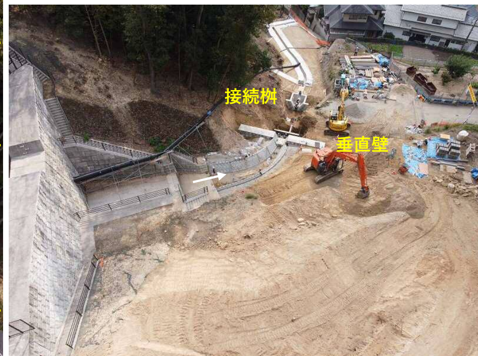
【流路 施工状況】
