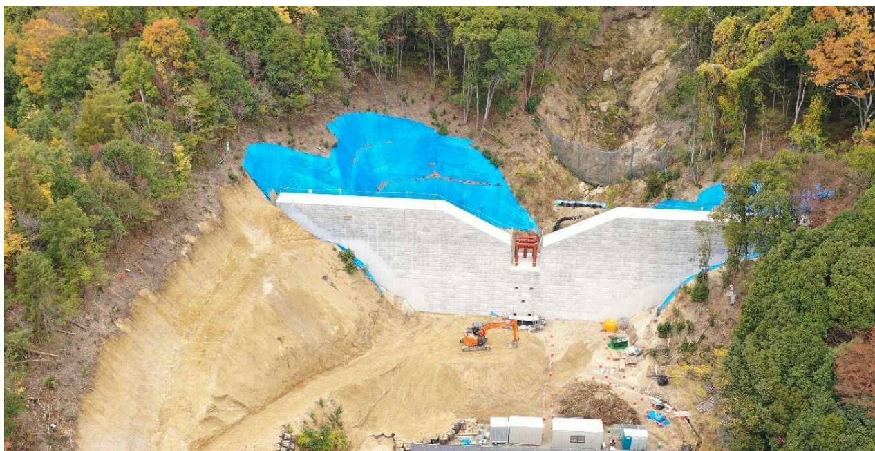
【施工状況（下流側より）】
