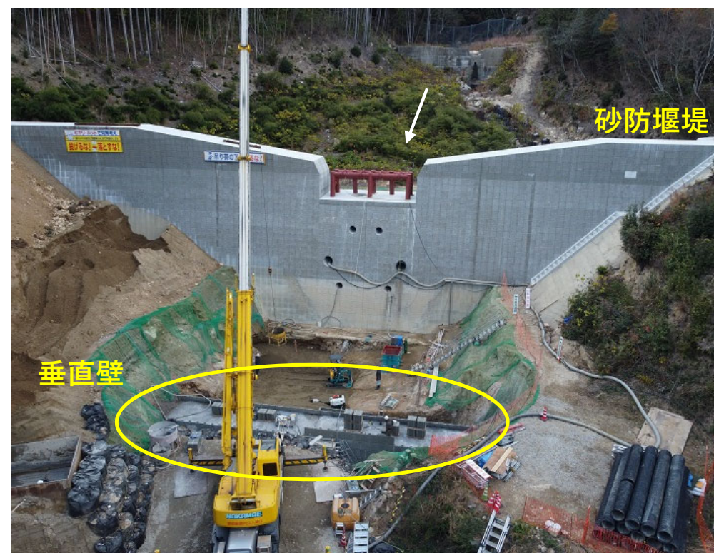
【前庭保護（垂直壁）の施工状況】
