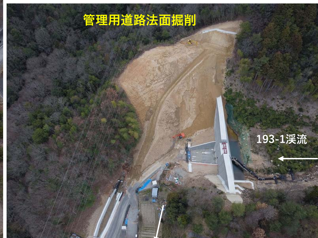
【管理用道路法面掘削の施工状況】
