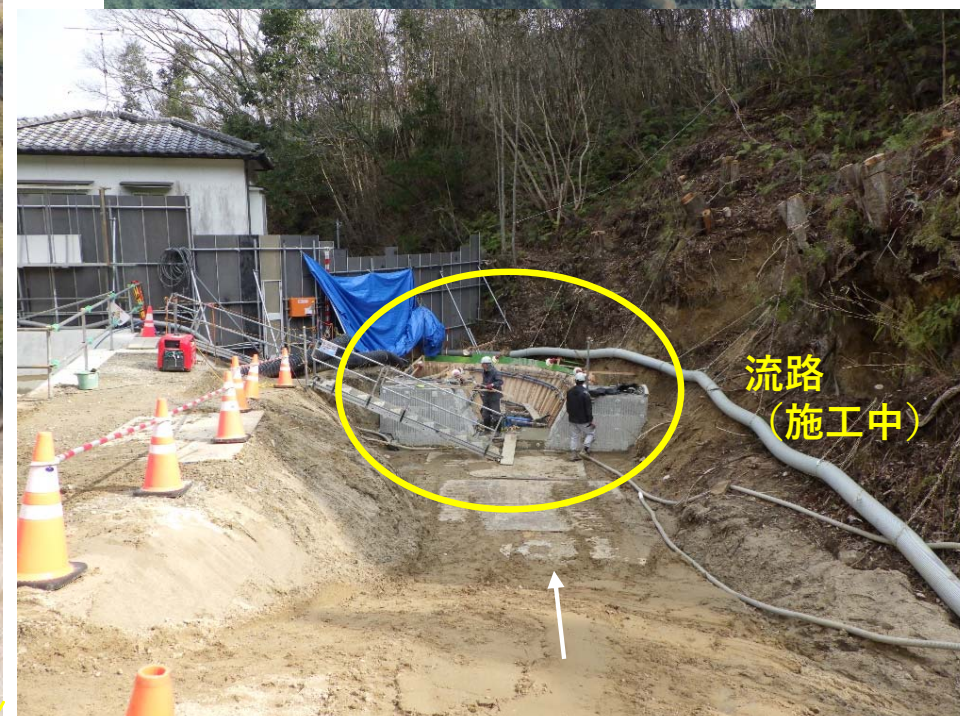
【施工状況 (床固・流路護岸)】
