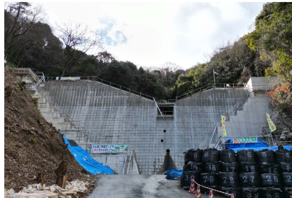
【施工箇所（下流側より）】
