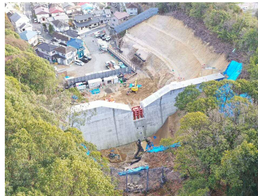
【施工状況（上流側より）】
