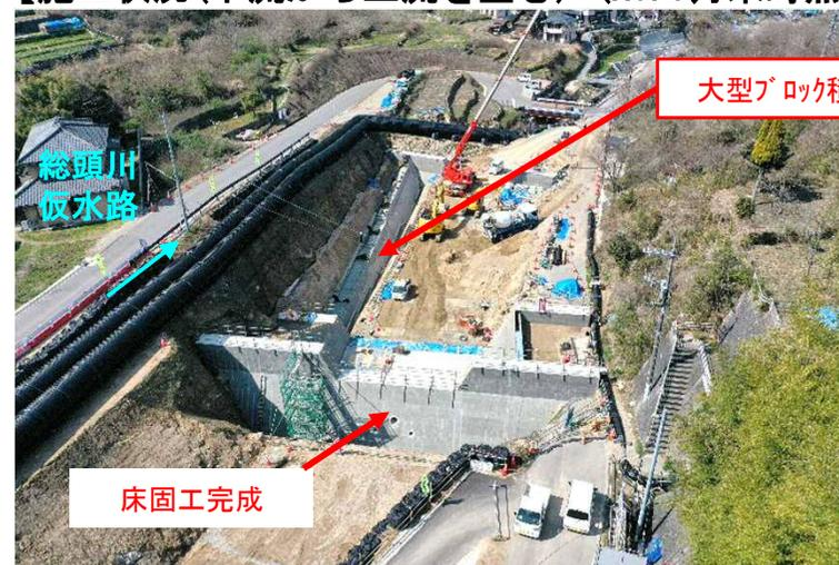
【床固工のコンクリート打設状況（上流から下流を望む）】
