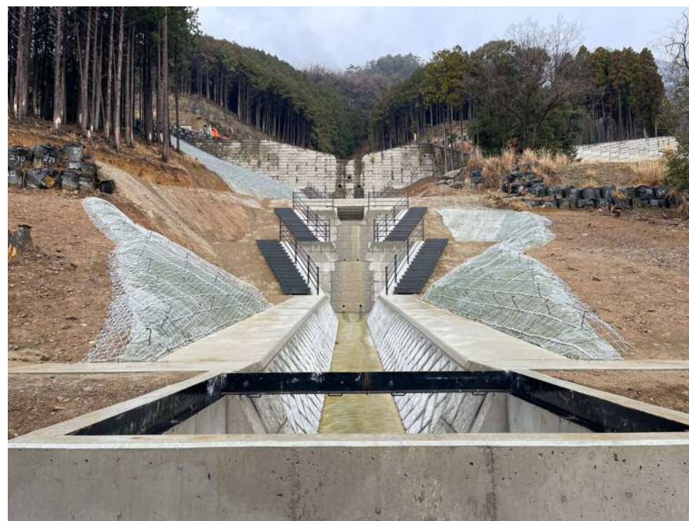
【流路工完成状況】
