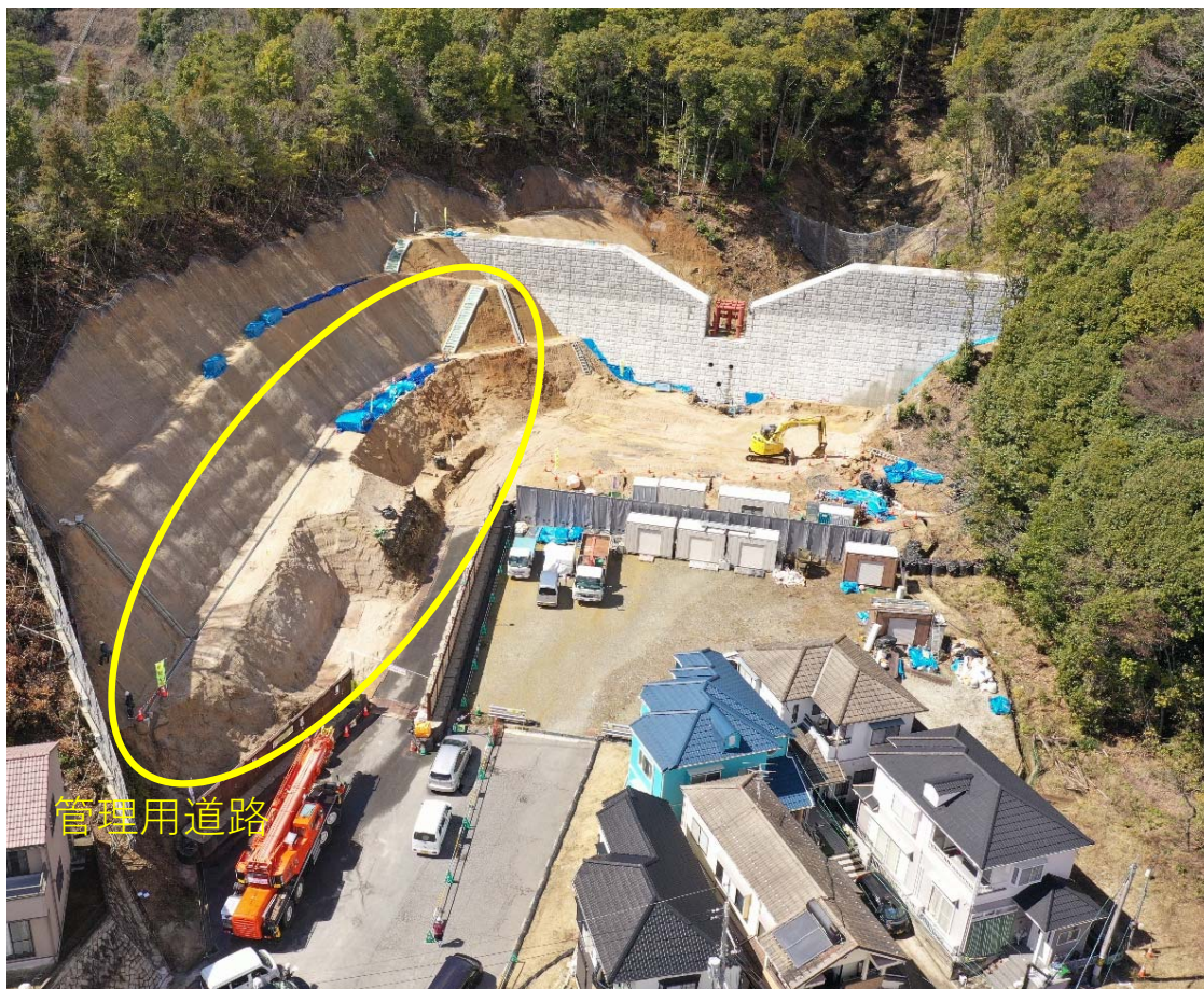
【施工状況（下流側より）】
