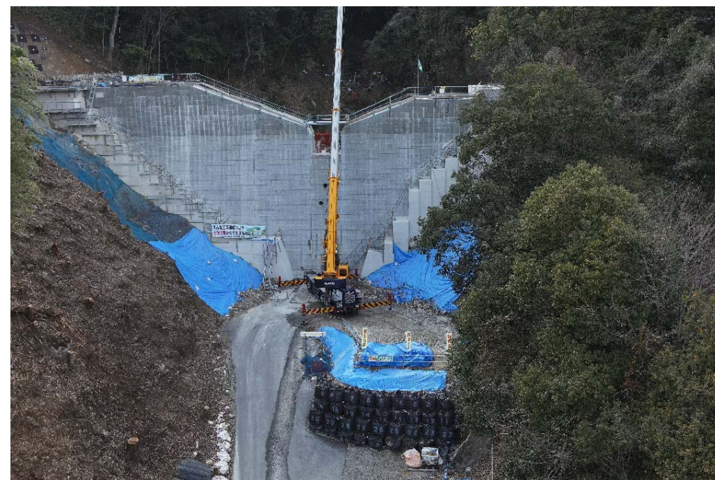
【施工箇所（下流側より）】
