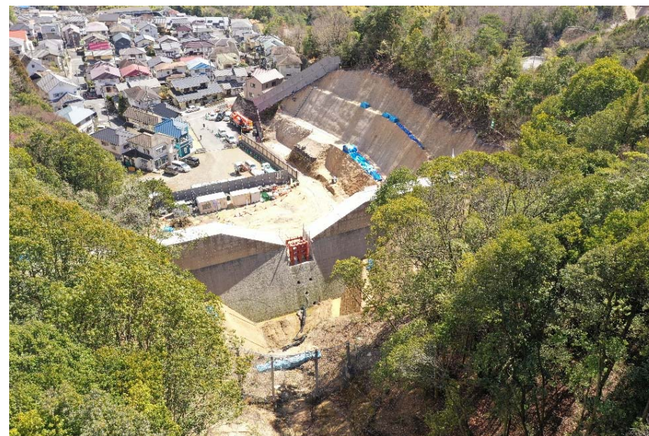
【施工状況（上流側より）】
