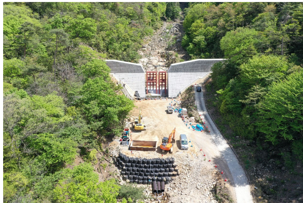
【大谷川 3 号砂防堰堤・管理用階段を施工中】
