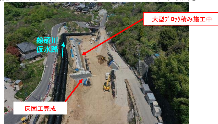
【大型ブロック積施工状況（上流から下流を望む）】
