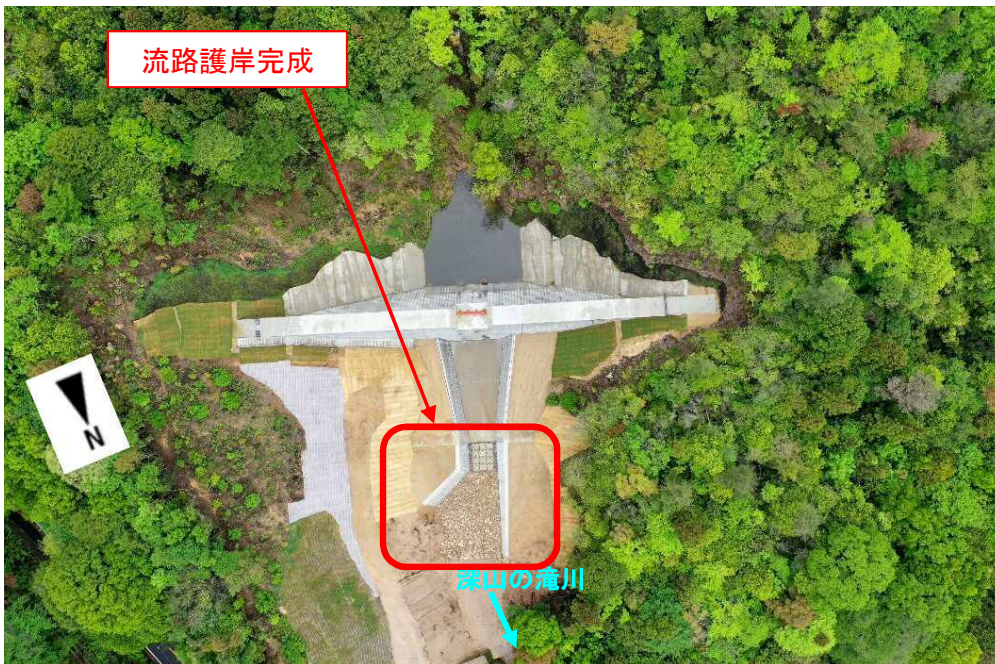
【深山の滝川 1号砂防堰堤状況】
