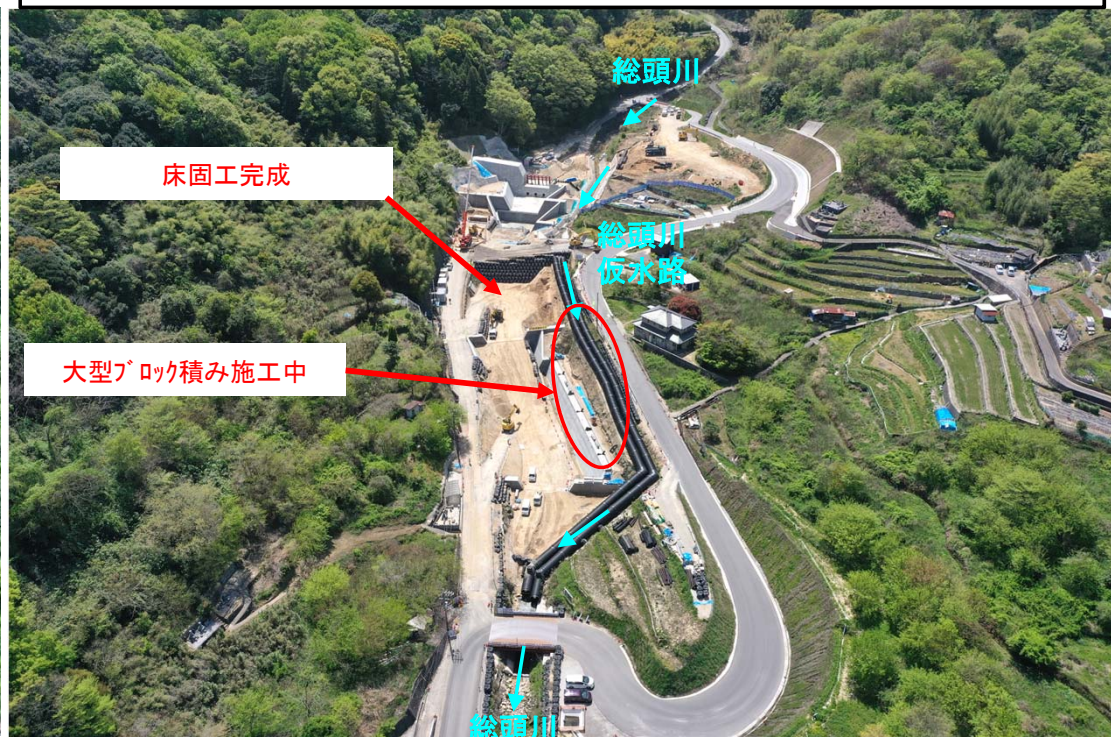
【施工状況（下流から上流を望む）（R6. 4月中旬時点）】
