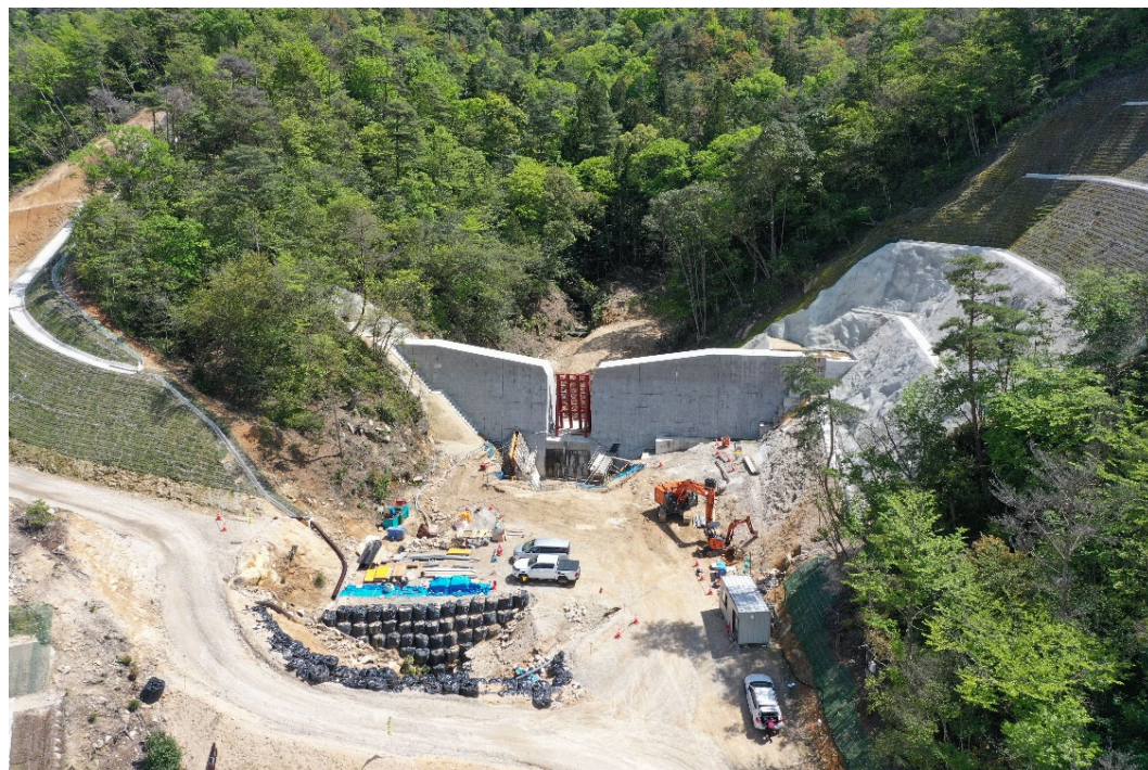
【大谷川 2 号砂防堰堤・前庭保護工を施工中】
