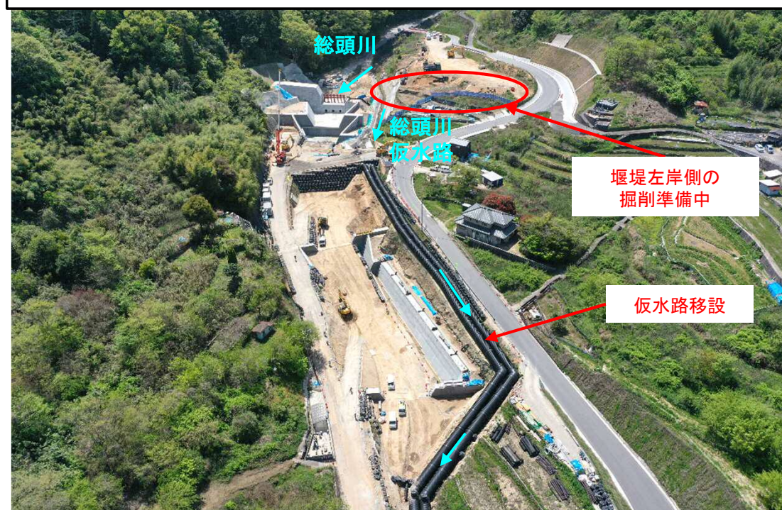
【施工状況（下流から上流を望む）（R6. 4月中旬時点）】
