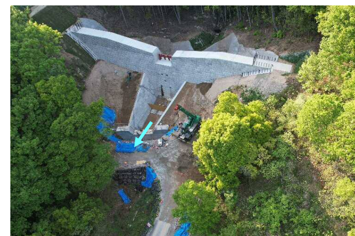
【前庭保護工の施工状況】
