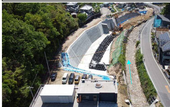
全景(上流側より)
