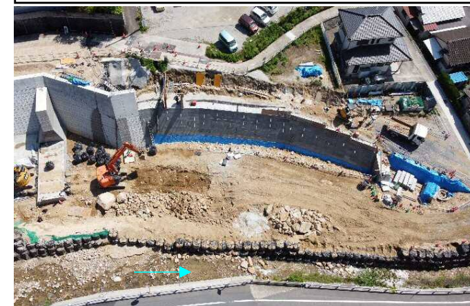
左岸下流側(大型ブロック積み施工中)
