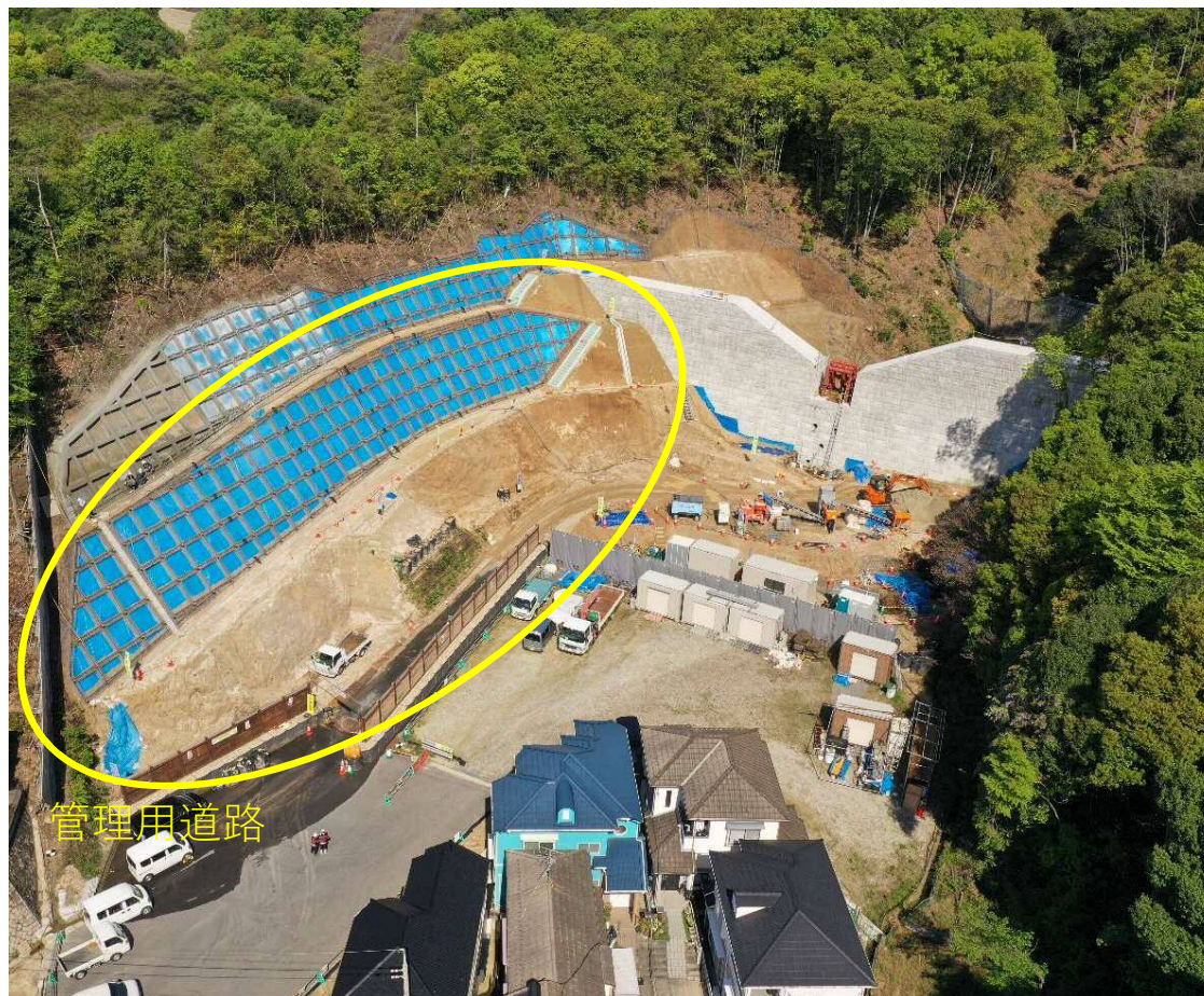
【施工状況（下流側より）】
