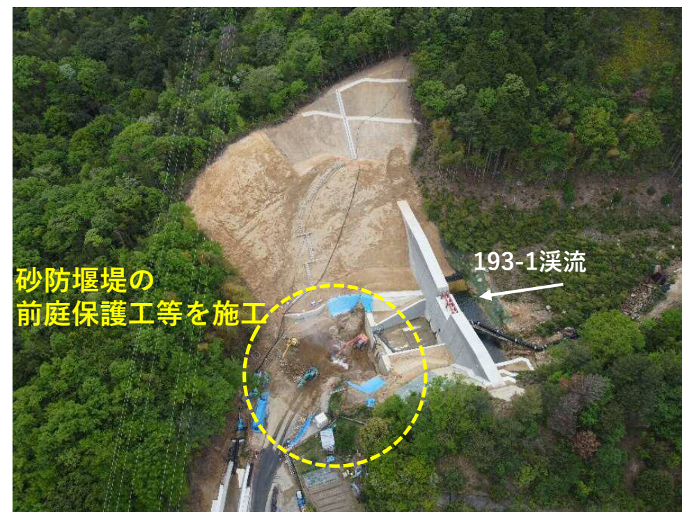
【管理用道路法面掘削の施工状況】
