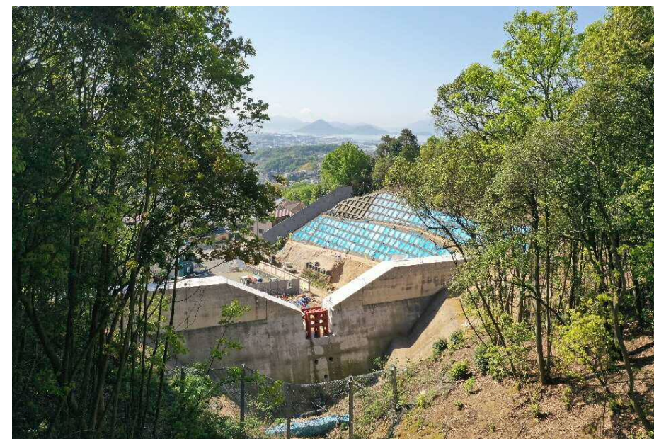
【施工状況（上流側より）】
