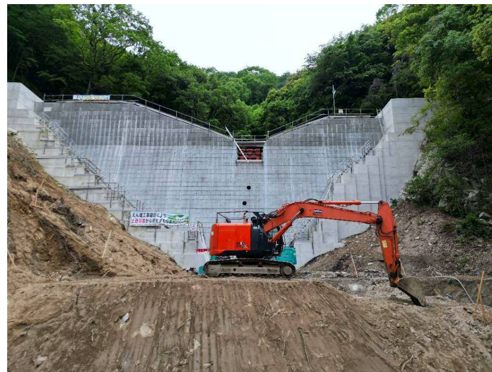
【施工箇所（下流側より）】
