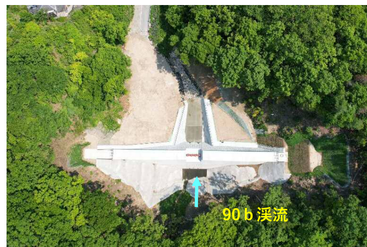
【前庭保護工の施工状況】
