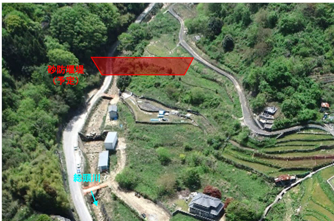
【総頭川砂防堰堤施工状況(着手前R4. 4時点)】
