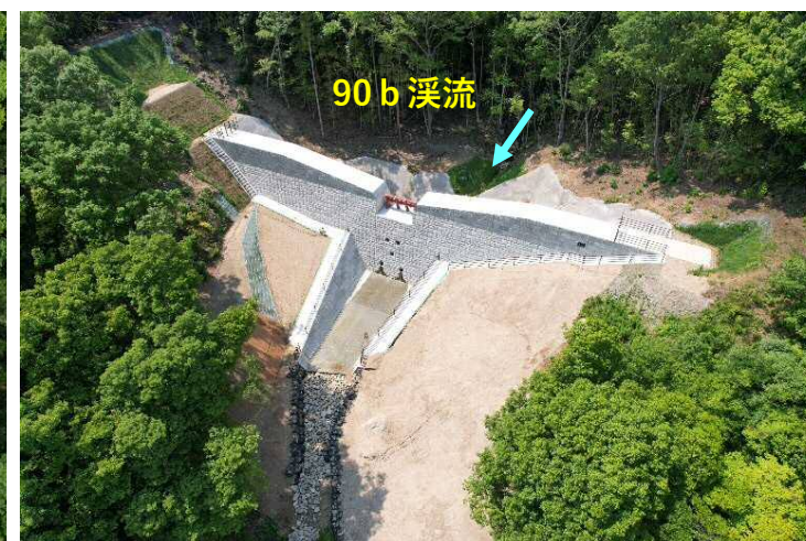
【前庭保護工の施工状況】
