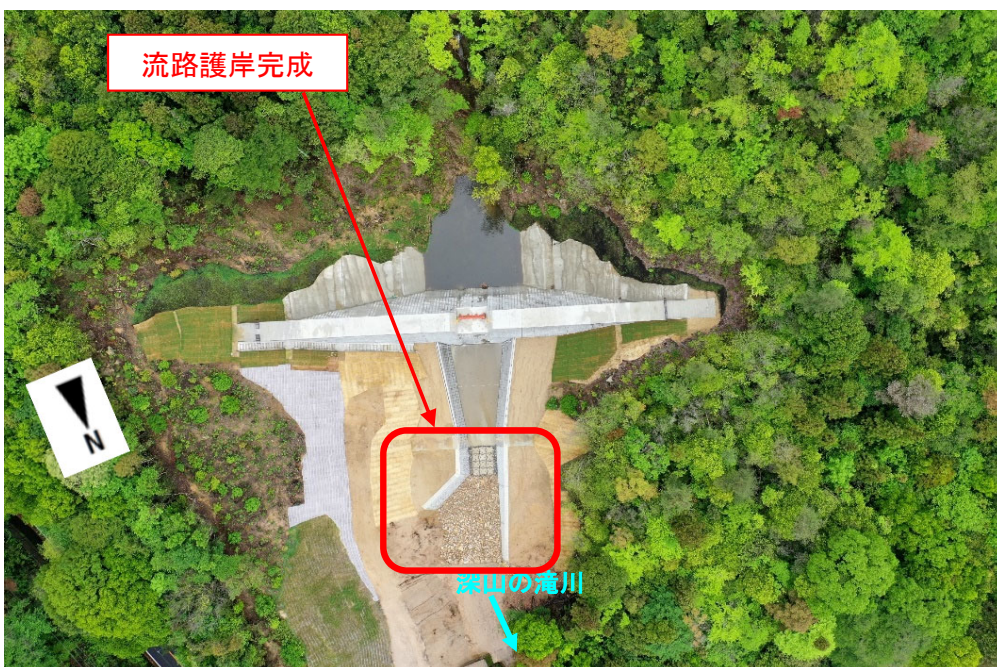
【深山の滝川 1号砂防堰堤状況】
