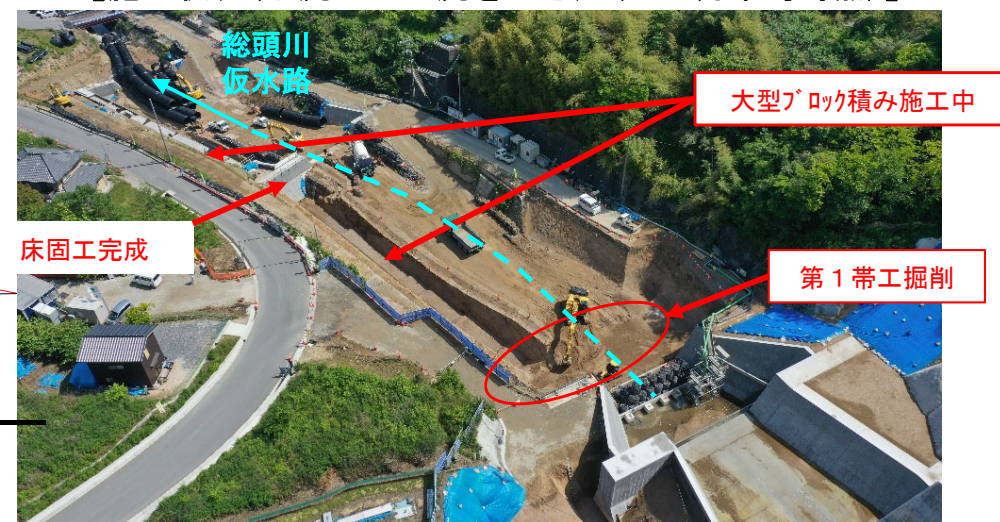
【大型ブロック積み施工状況（上流から下流を望む）】
