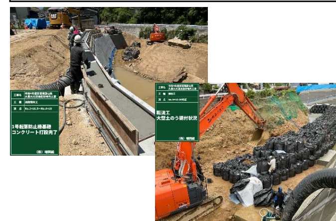
左岸下流側ブロック天端・仮締切施工中)
