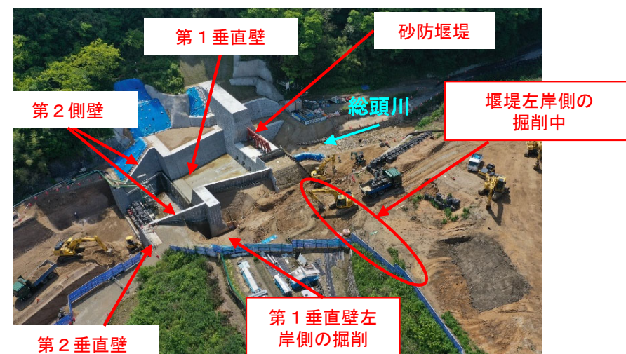
【砂防堰堤の施工状況（上空から望む）】
