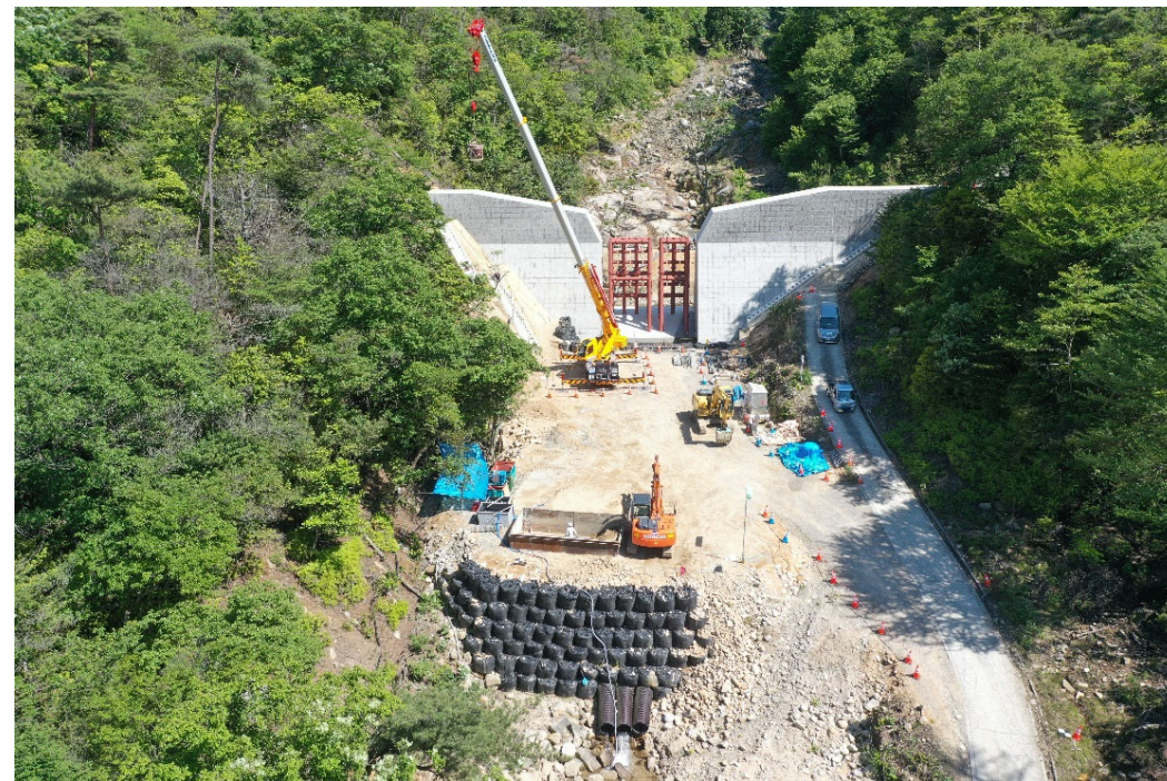
【大谷川 3 号砂防堰堤・管理用階段等を施工中】
