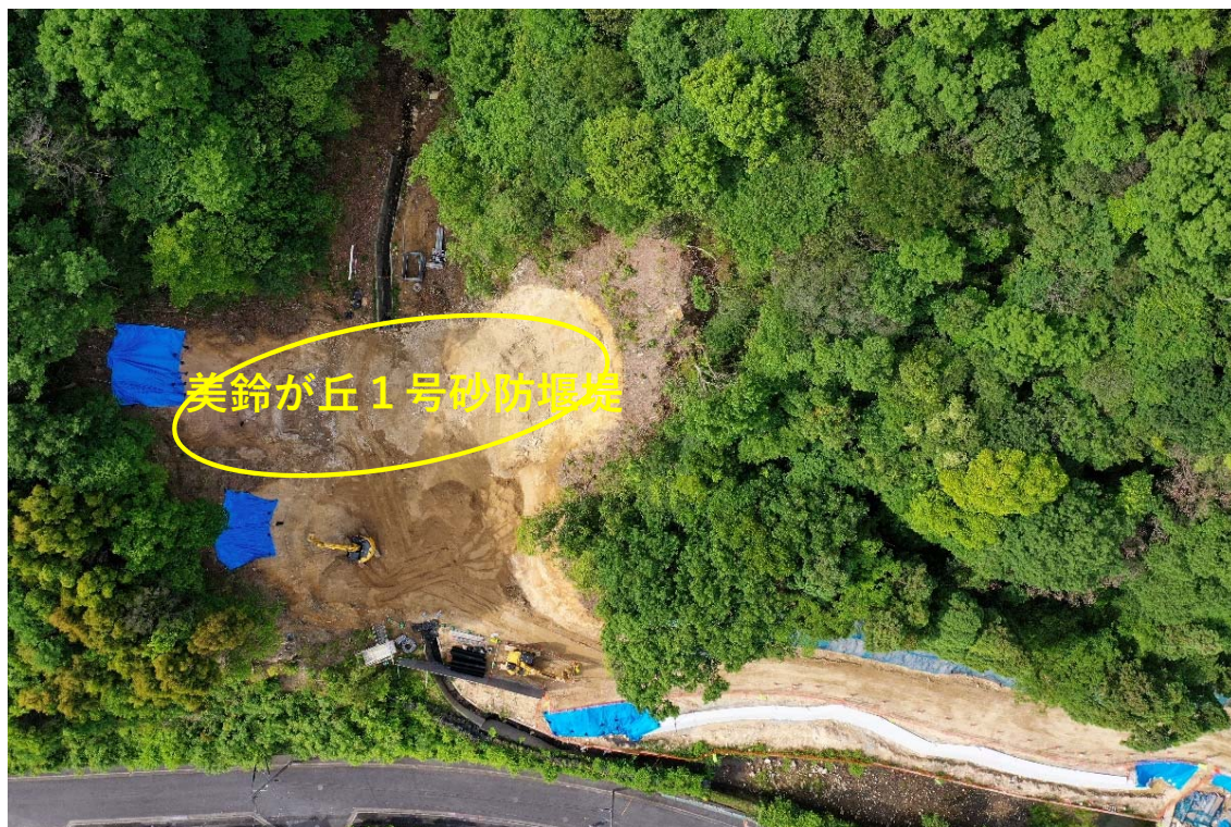
【施工状況（上空より）】
