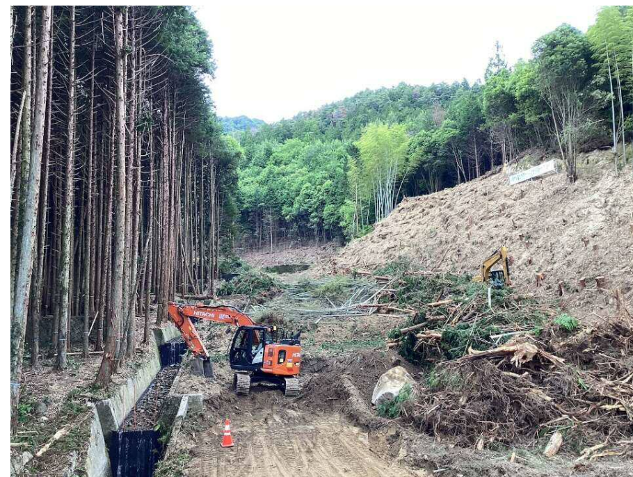
【施工状況（下流側より）】
