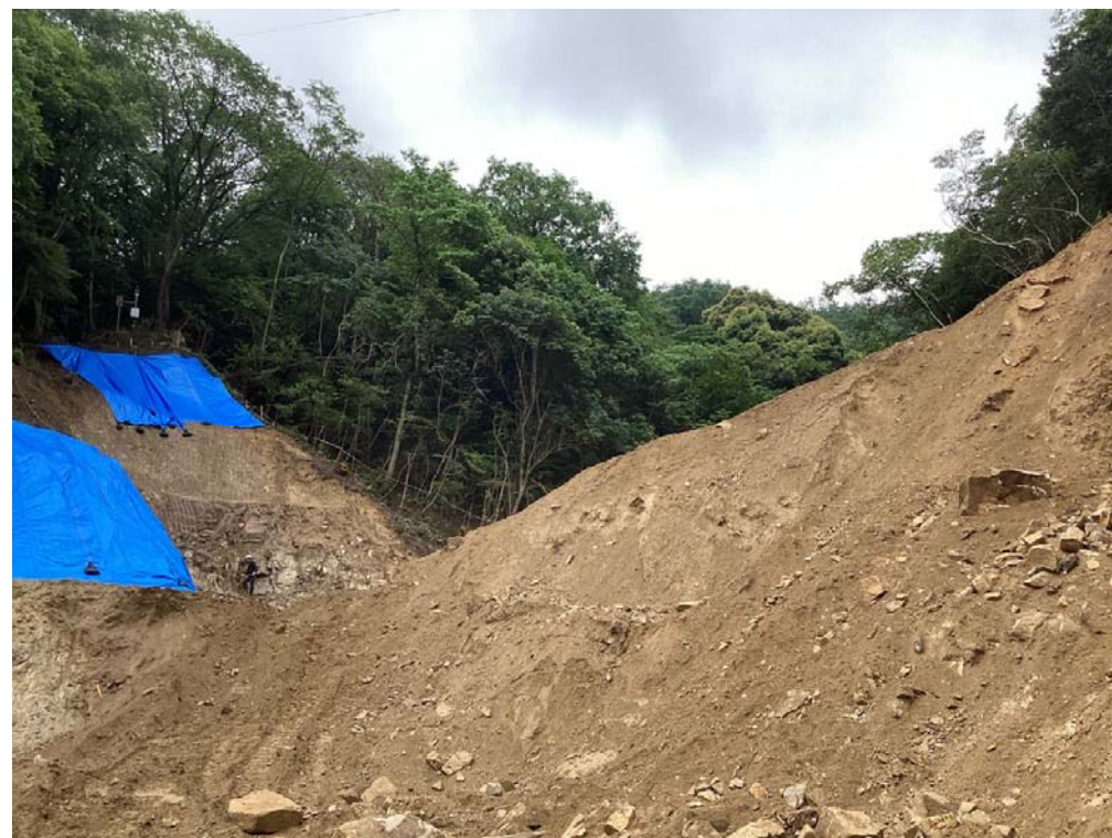
【施工状況（下流側より）】
