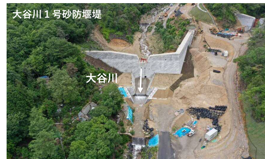
【大谷川1号砂防堰堤】
