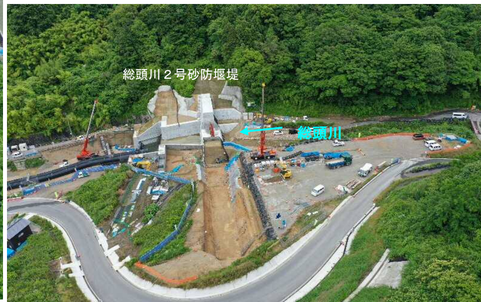
【砂防堰堤の施工状況(上空から望む)】
