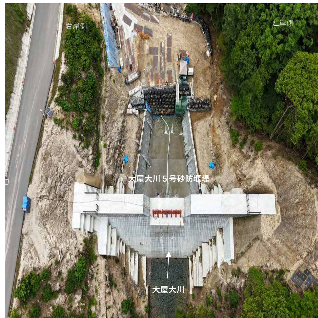
大屋大川 5 号砂防堰堤上流側
