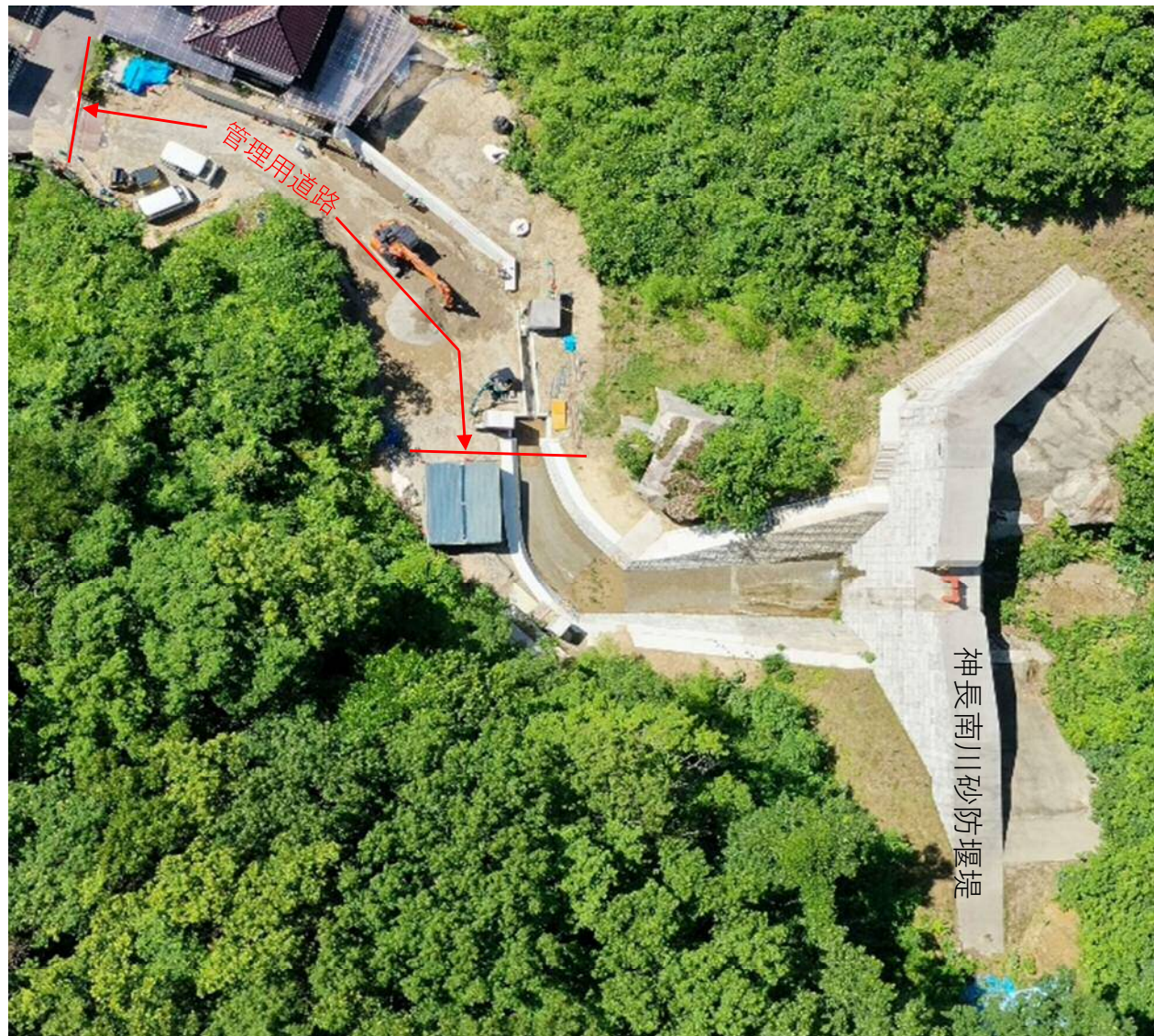
砂防堰堤全景（令和6年6月末現在）
