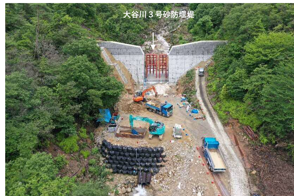
【大谷川 3 号砂防堰堤施工状況】
