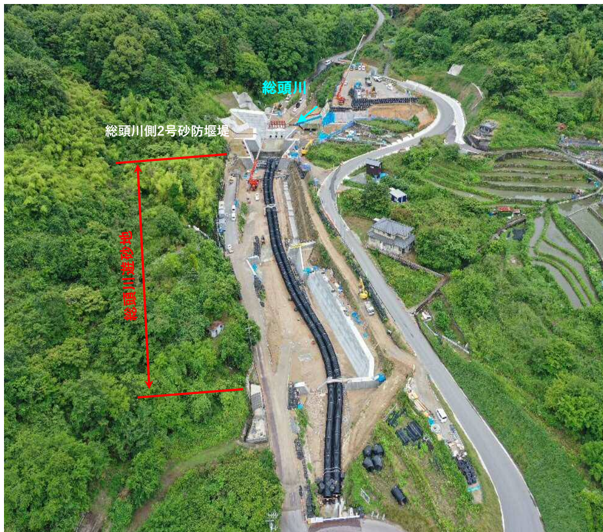
【施工状況(下流から上流を望む)】
