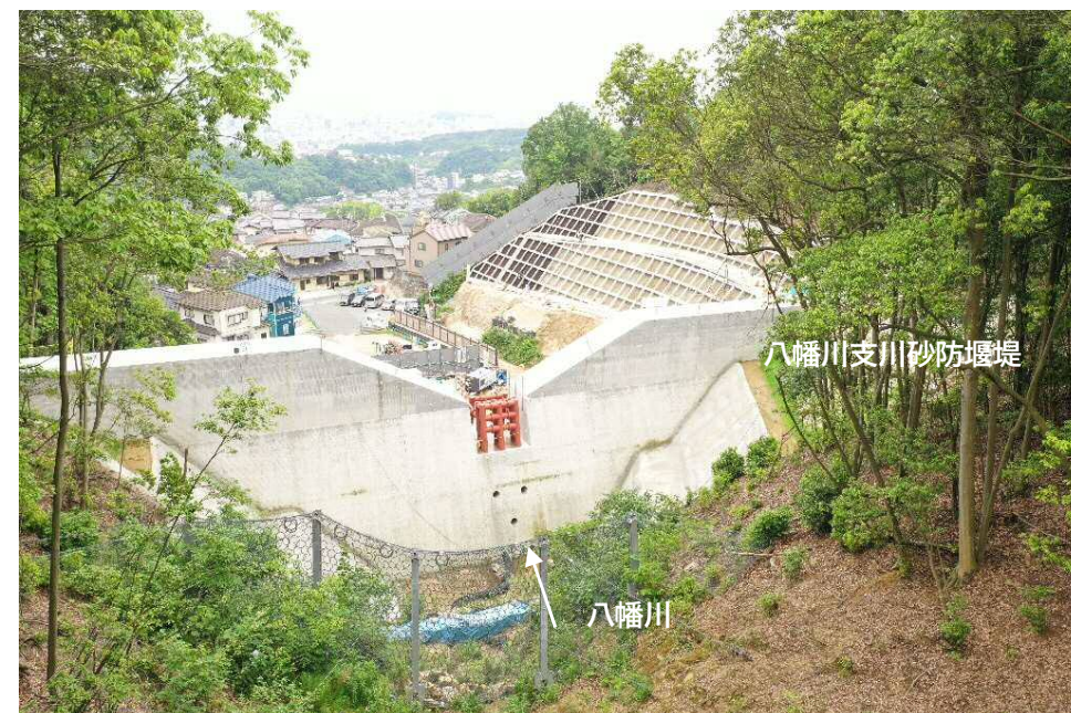
【施工状況（上流側より）】
