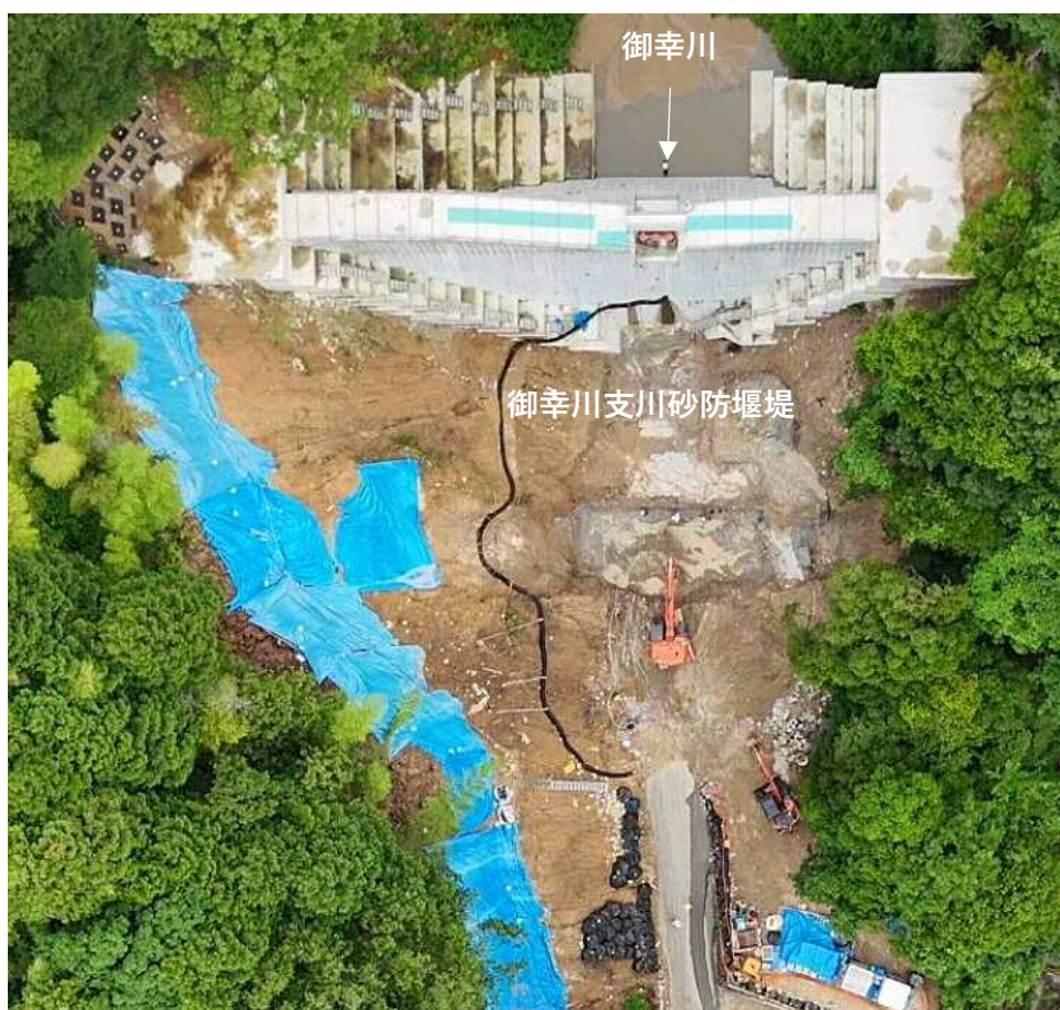
【施工状況（上空より）】
