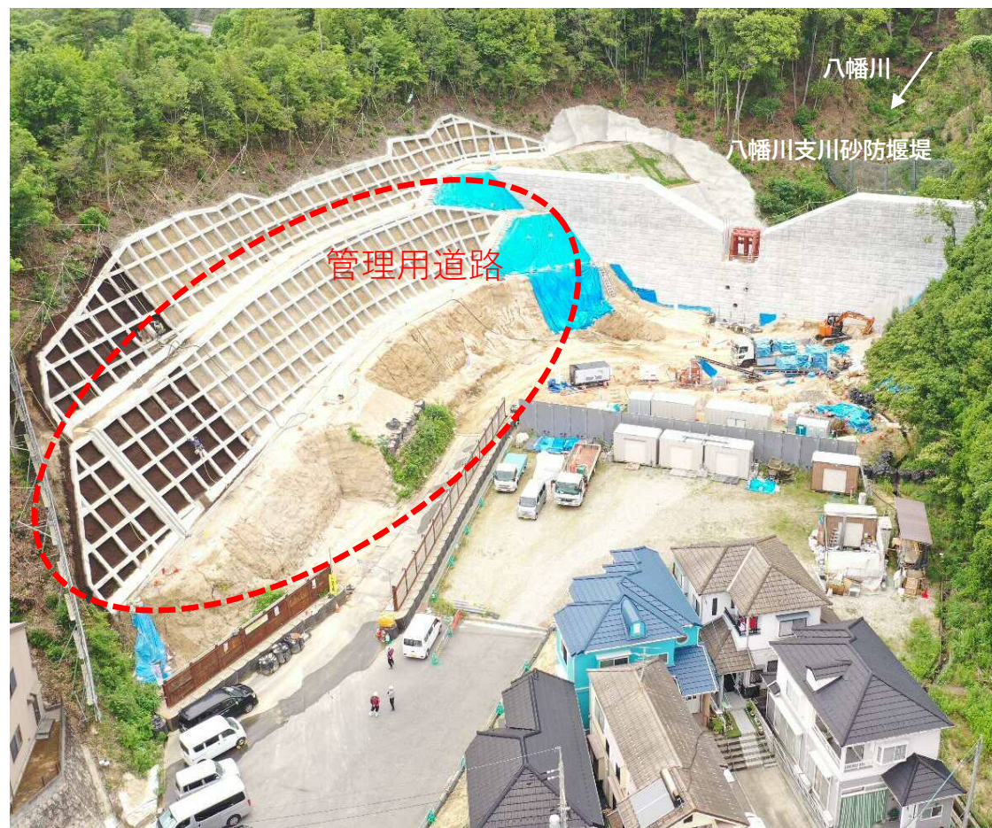
【施工状況（下流側より）】
