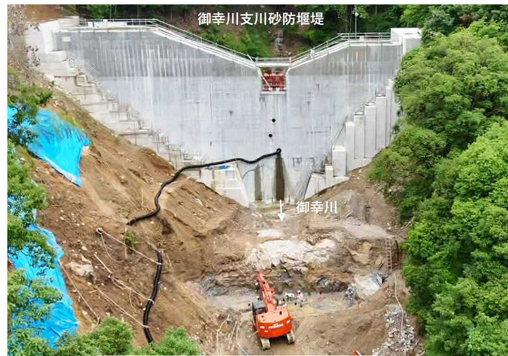
【施工箇所（下流側より）】
