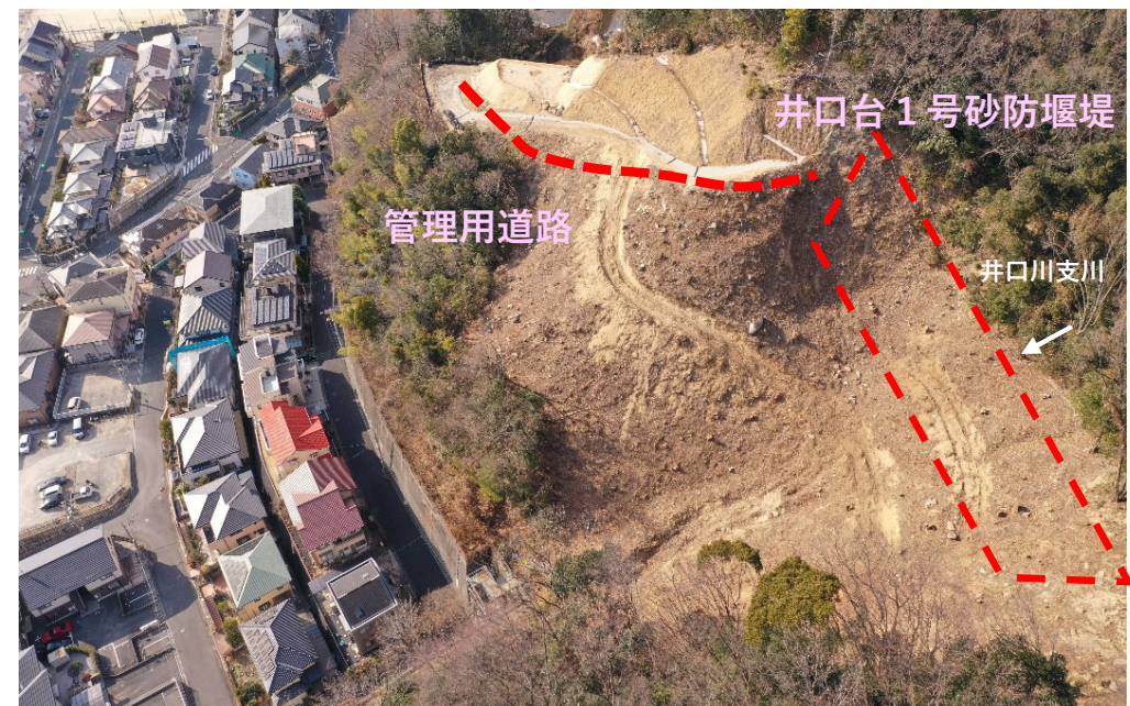
【上空より（井口台1号堰堤側から）】
