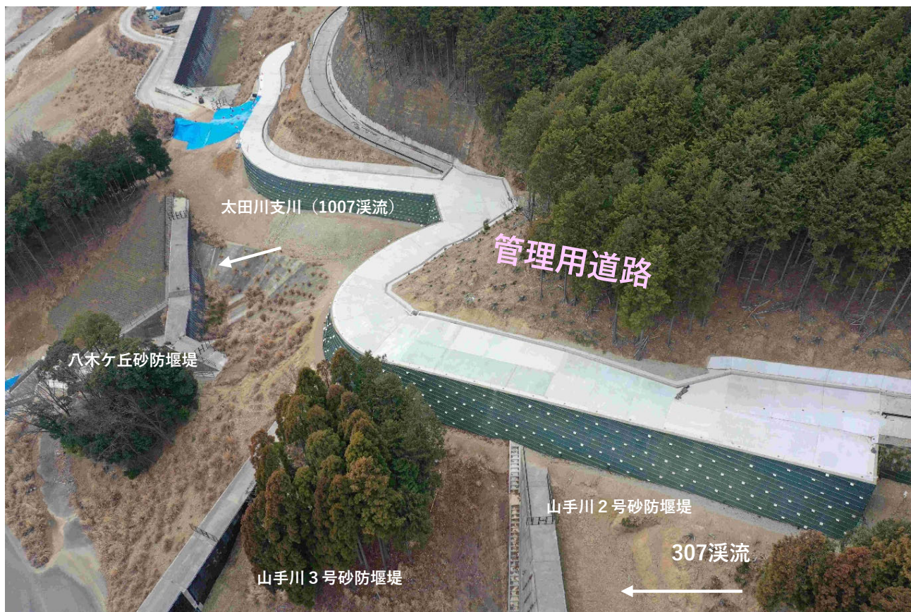
【施工状況（上空より）】
