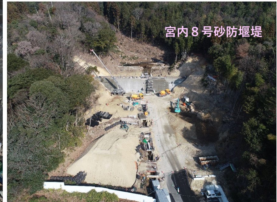
【施工状況（上空より）】
