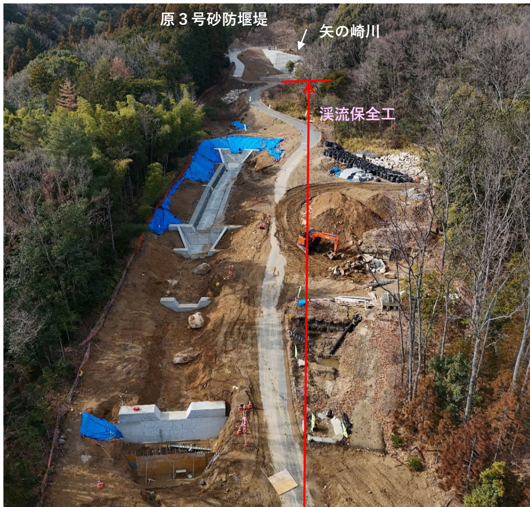
【全景（原3号溪流保全工）】
