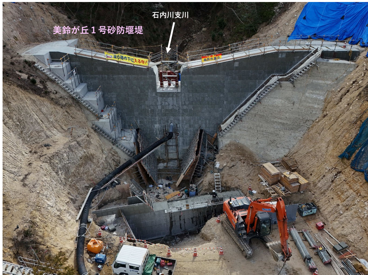
【施工状況（下流側より）】
