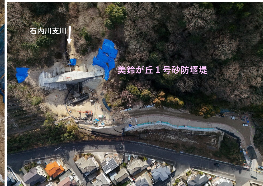
【施工状況（上空より）】
