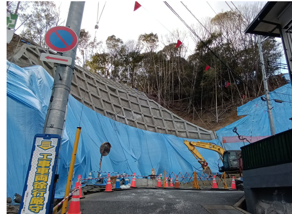
【管理用道路 施工状況】
