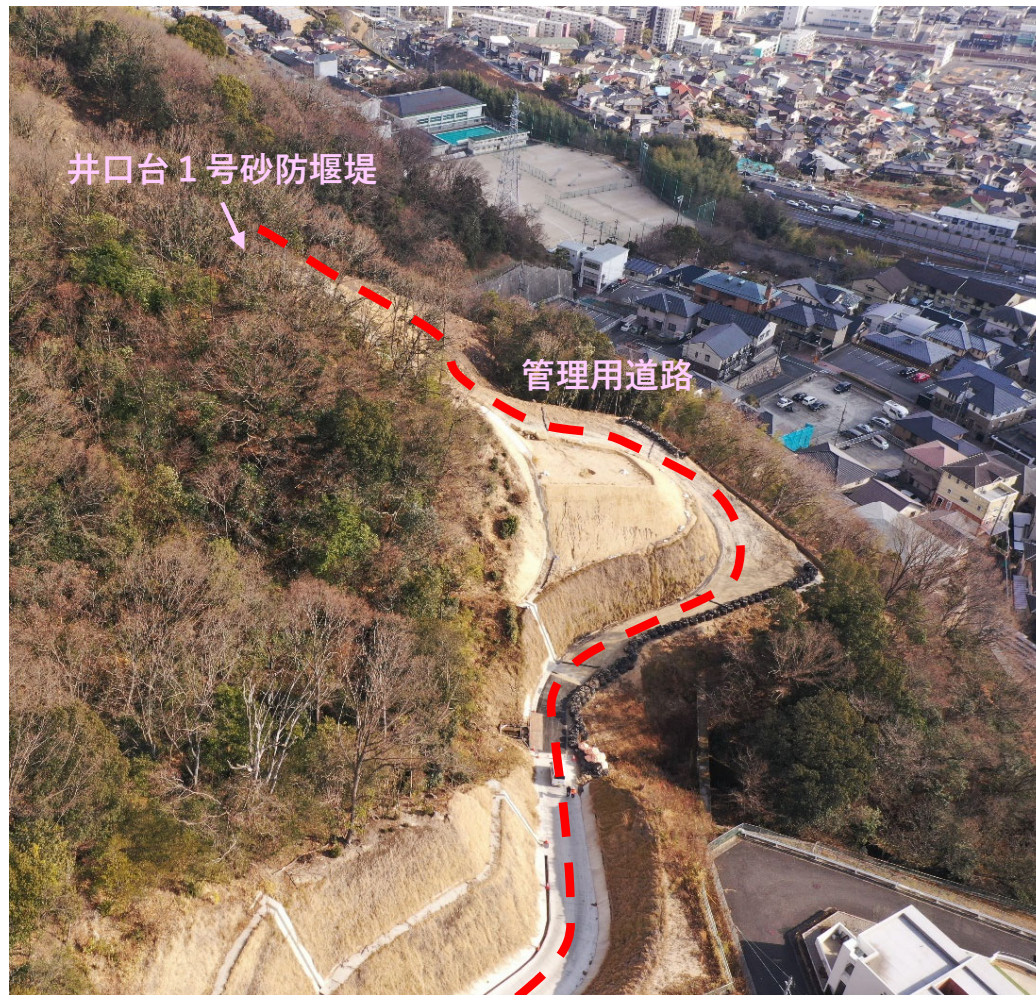
【上空より（井口台1号管理道側から）】
