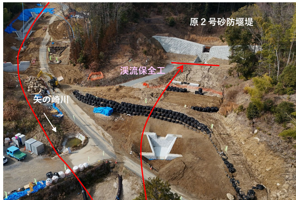
【全景（原2号溪流保全工）】
