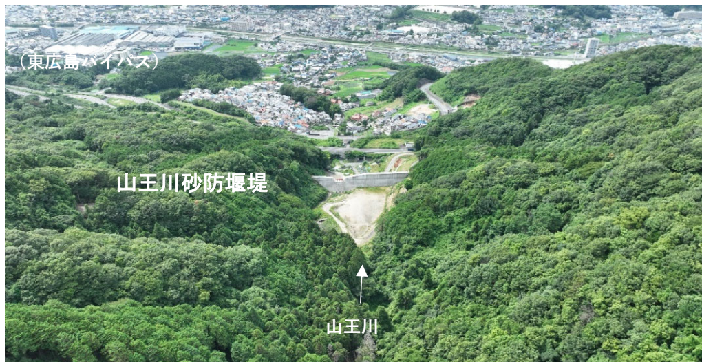
【施工状況（上空より）】
