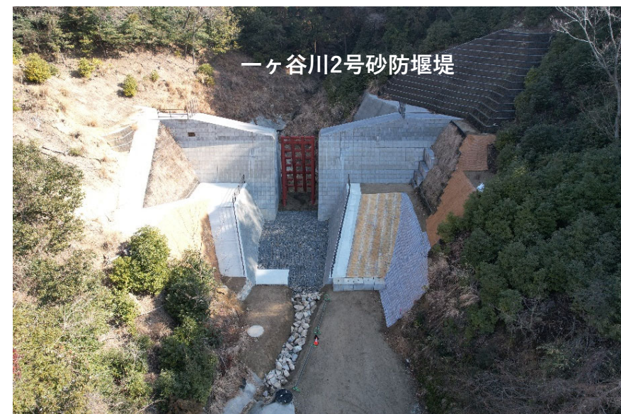
【一ヶ谷川2号砂防堰堤 全景】
