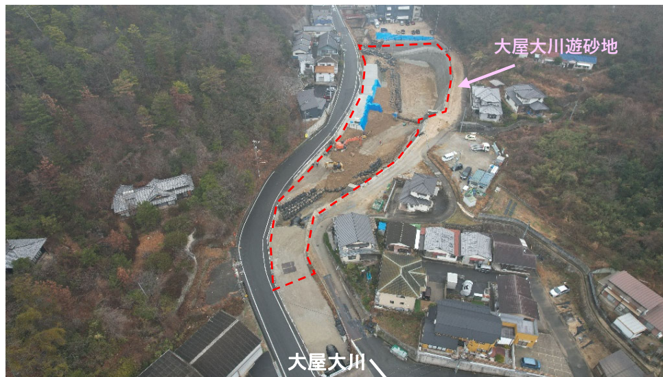
【施工状況（上空より）】
