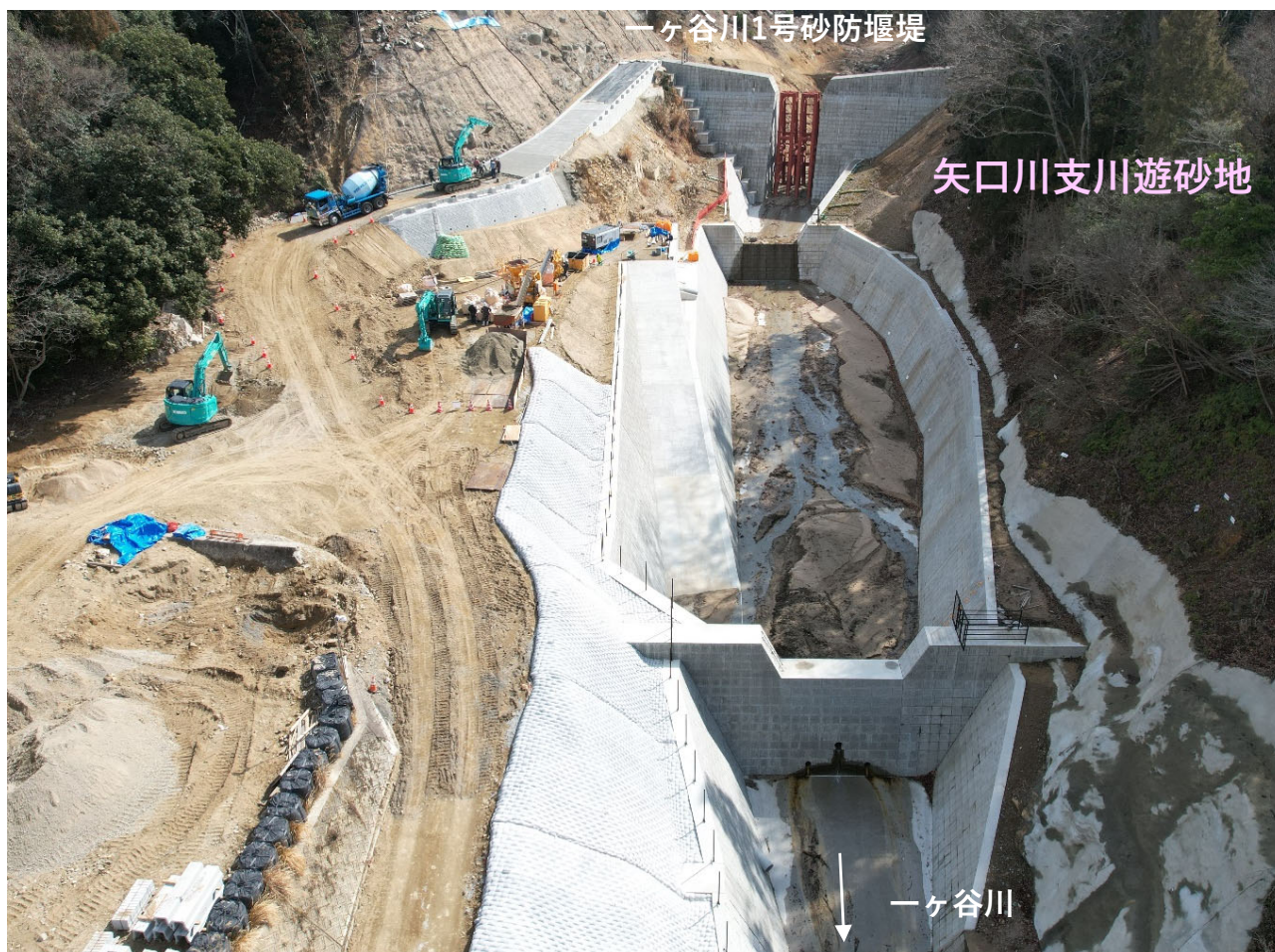
【矢口川支川遊砂地 全景】
