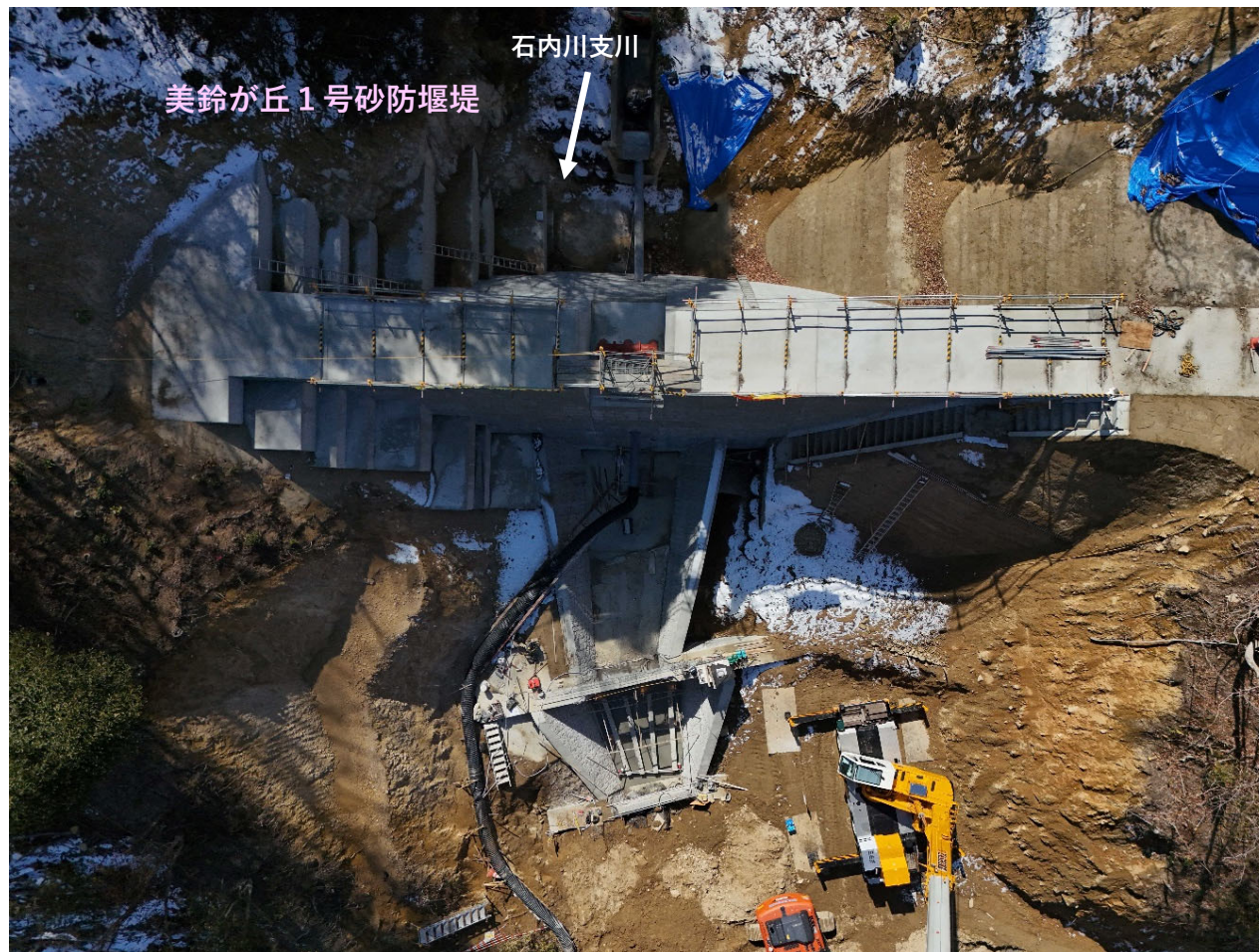
【施工状況（下流側より）】
