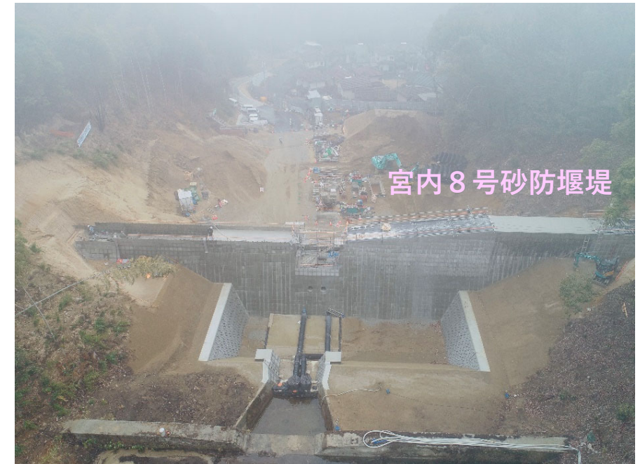
【施工状況（上流より）】
