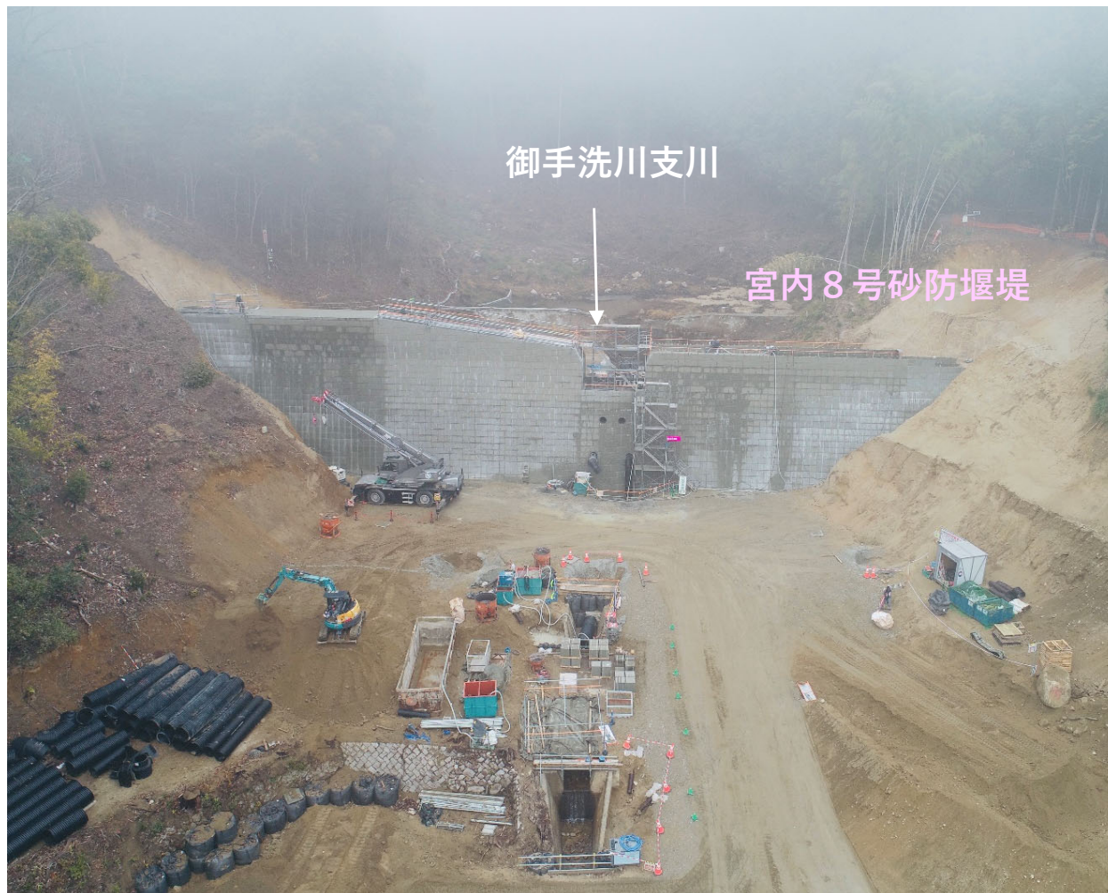
【施工状況（下流より）】
