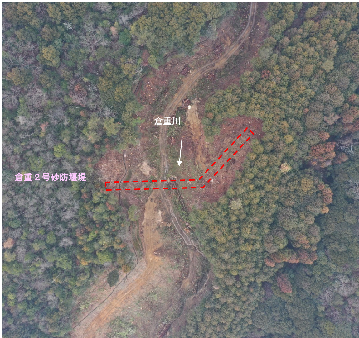
【全景 堰堤真上から】
