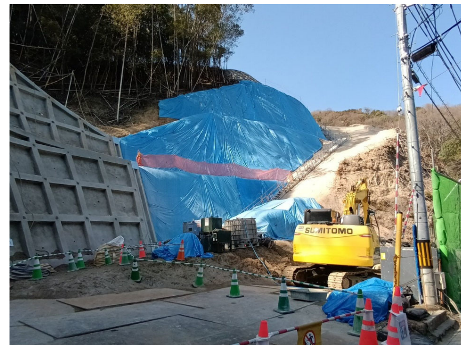
【管理用道路 施工状況】
