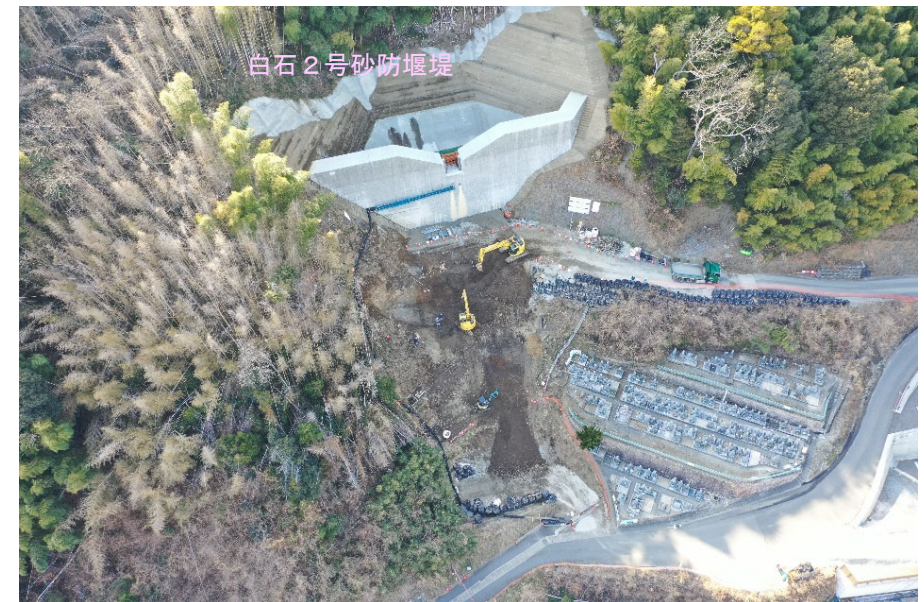
【施工状況（下流側より）】
