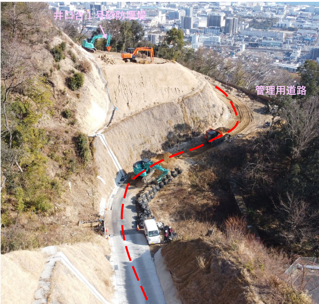
【上空より（井口台1号管理道側から）】
