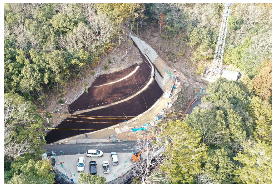
【法面工 施工状況】
