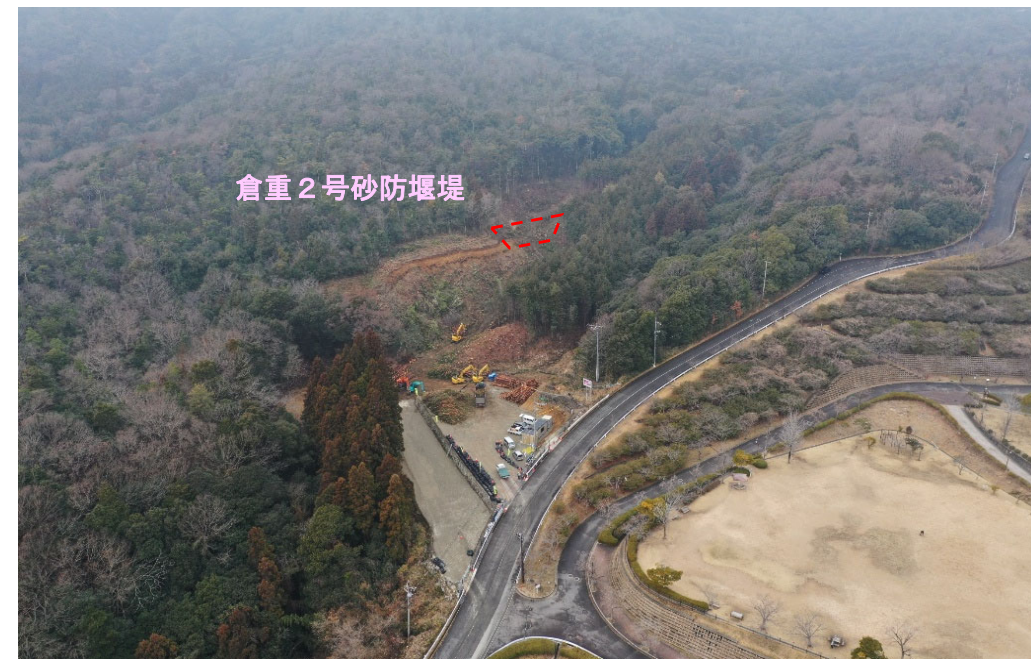
【全景 堰堤下流から】
