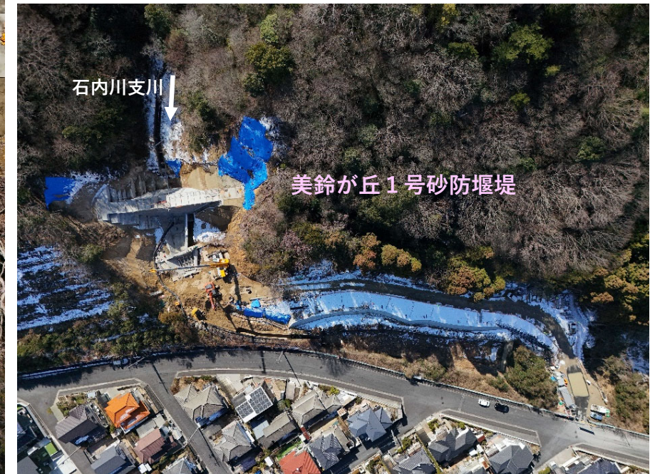
【施工状況（上空より）】
