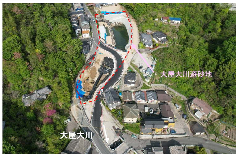
【施工状況（上空より）】
