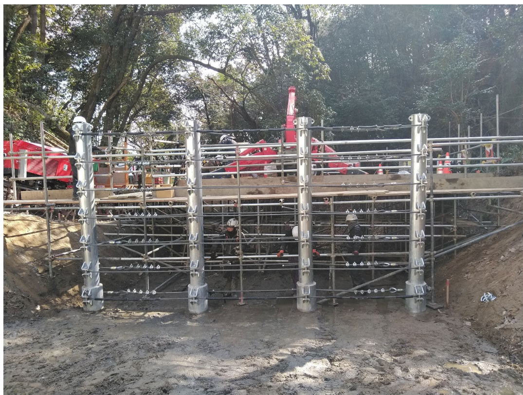
【施工状況：上流側土砂対策施工状況】 (御幸川支川砂防堰堤上流側土石流対策工)
