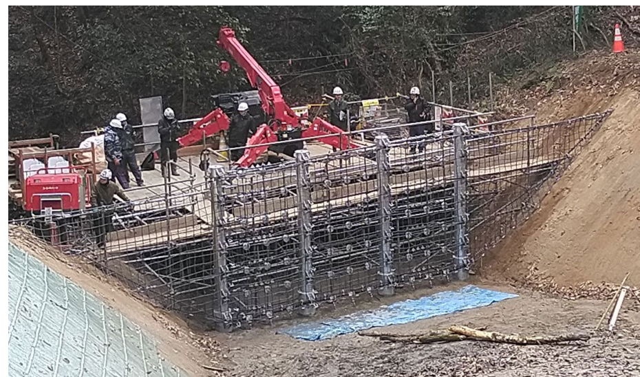
【施工状況：設置状況】 (御幸川支川砂防堰堤上流側土石流対策工)
