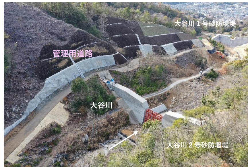
【施工状況②】
