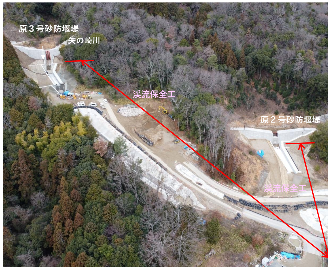
【全景（原3号・2号砂防堰堤下流）】
