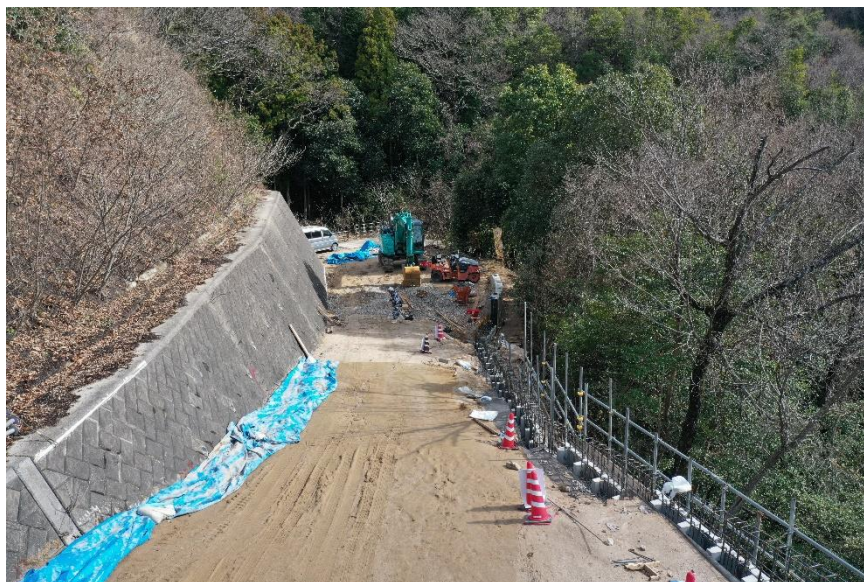
【五月が丘9号砂防堰堤管理道 施工状況】
