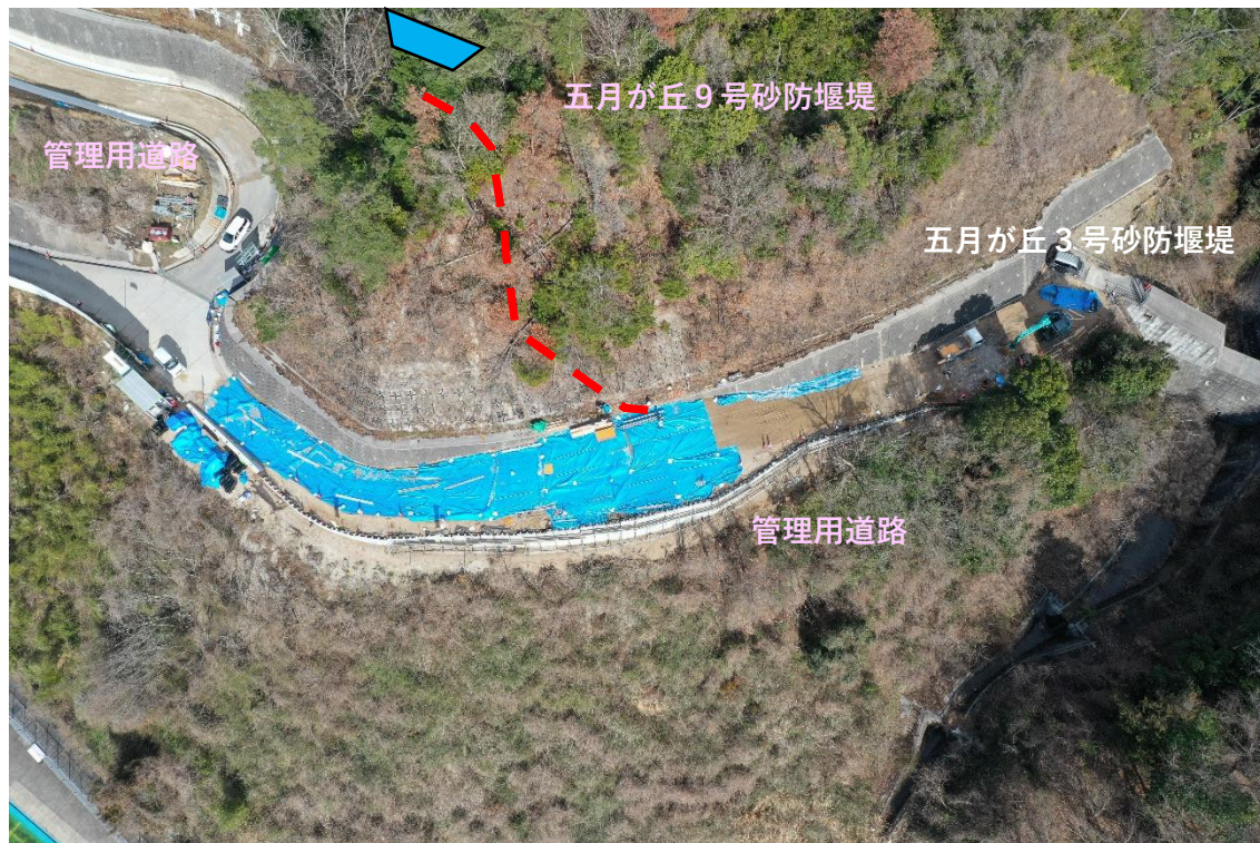
【五月が丘4、9号砂防堰堤管理道 施工状況】
