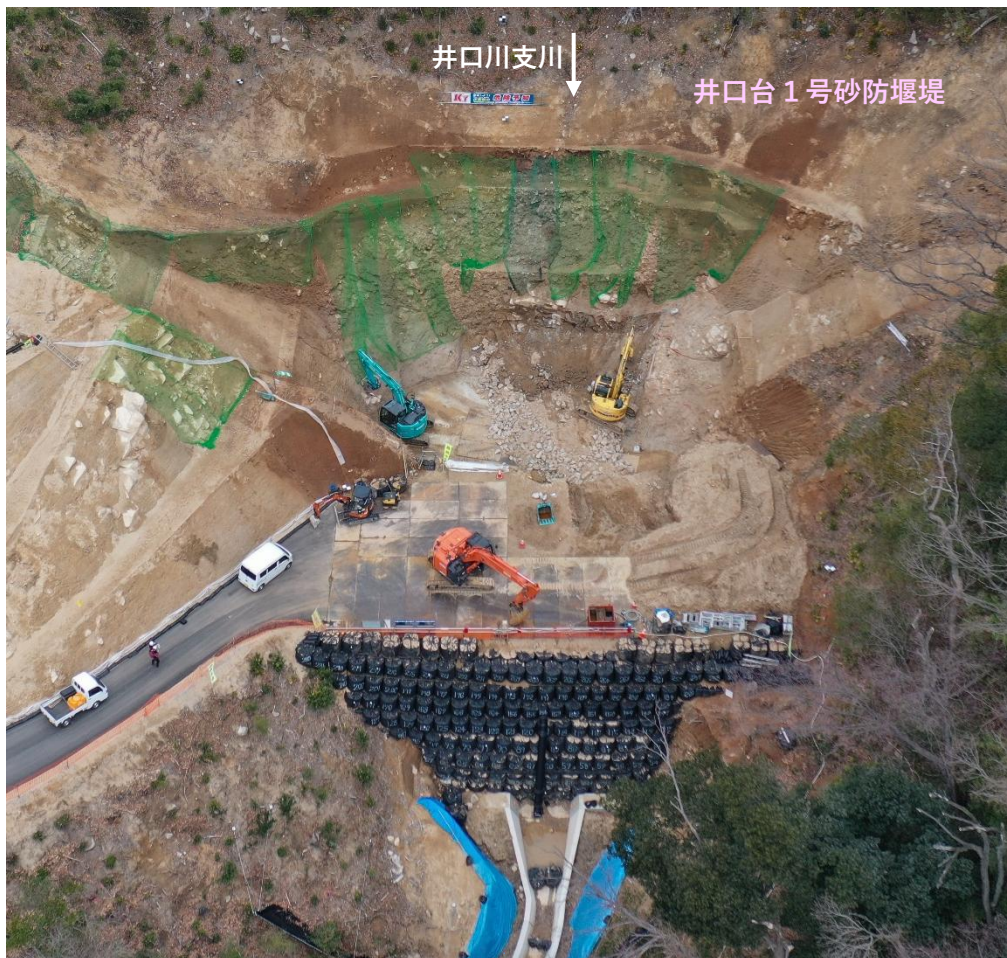
【 上空より (堰堤下流から) 】
