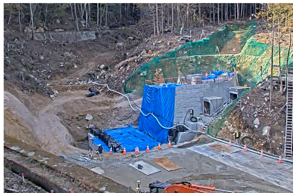
【施工状況（堰堤部施工状況）】
