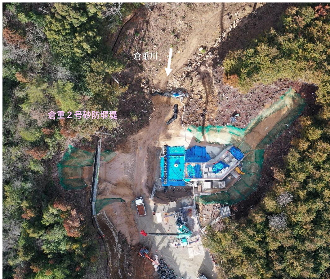
【全景 堰堤真上から】
