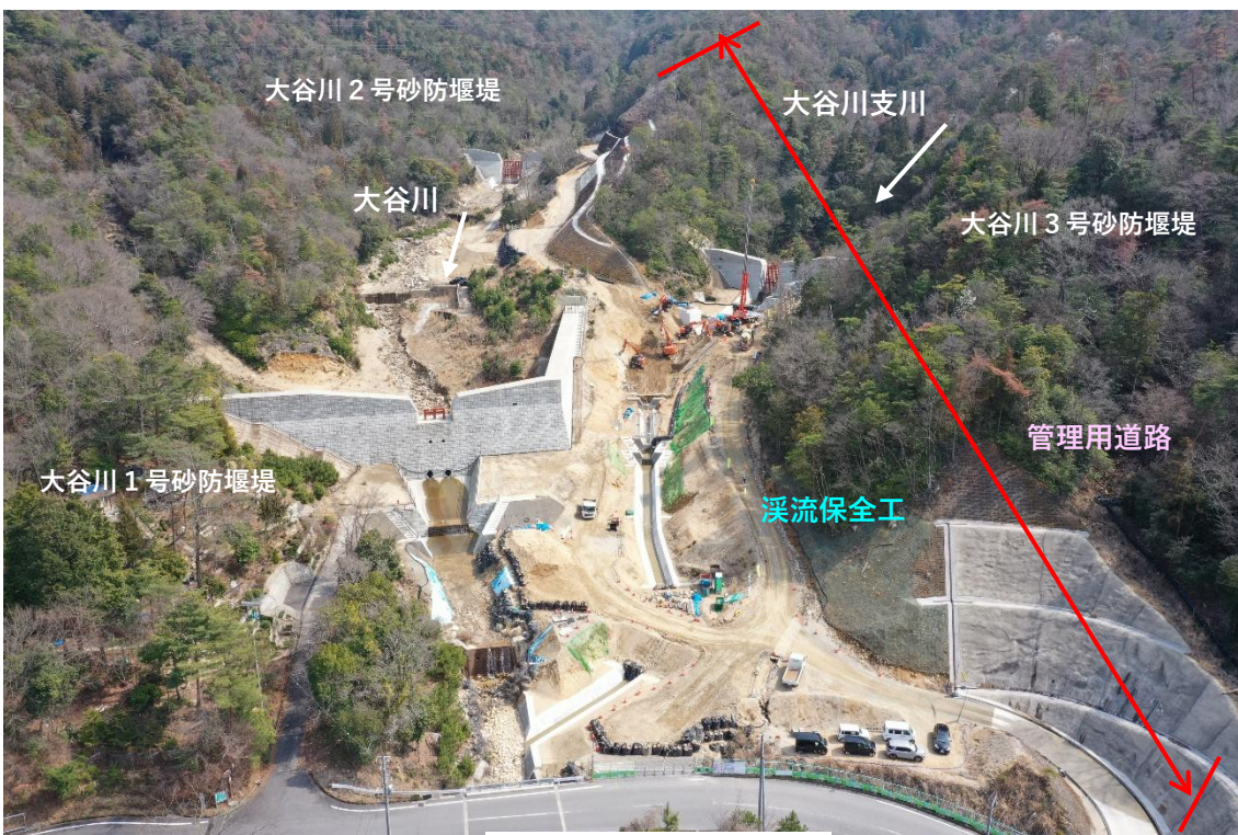
【施工状況①】
