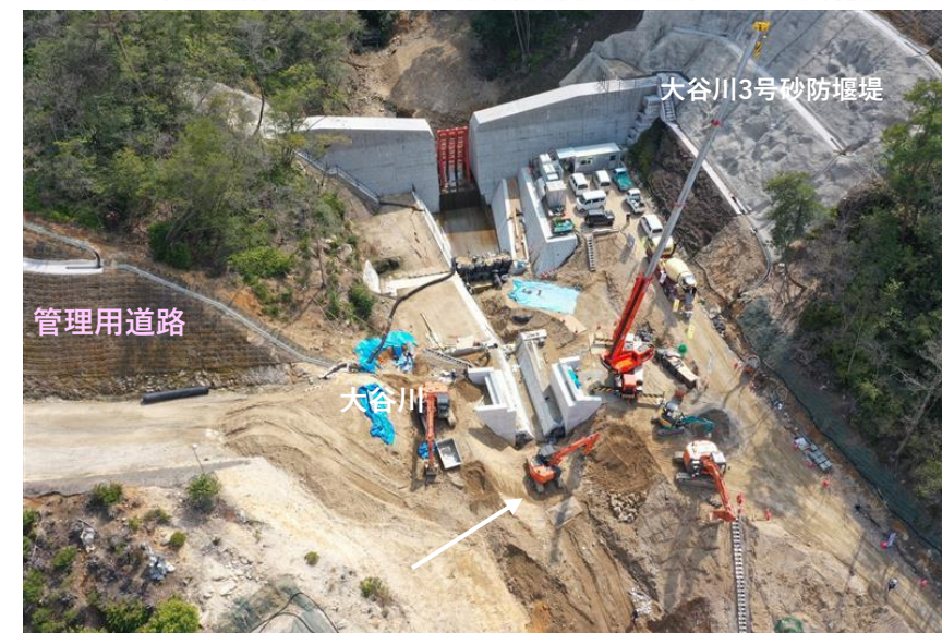
【施工状況②】
