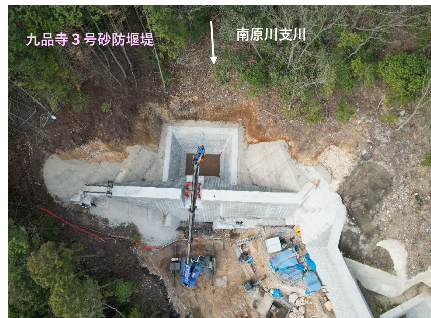
【砂防堰堤 堰堤上流側施工状況】
