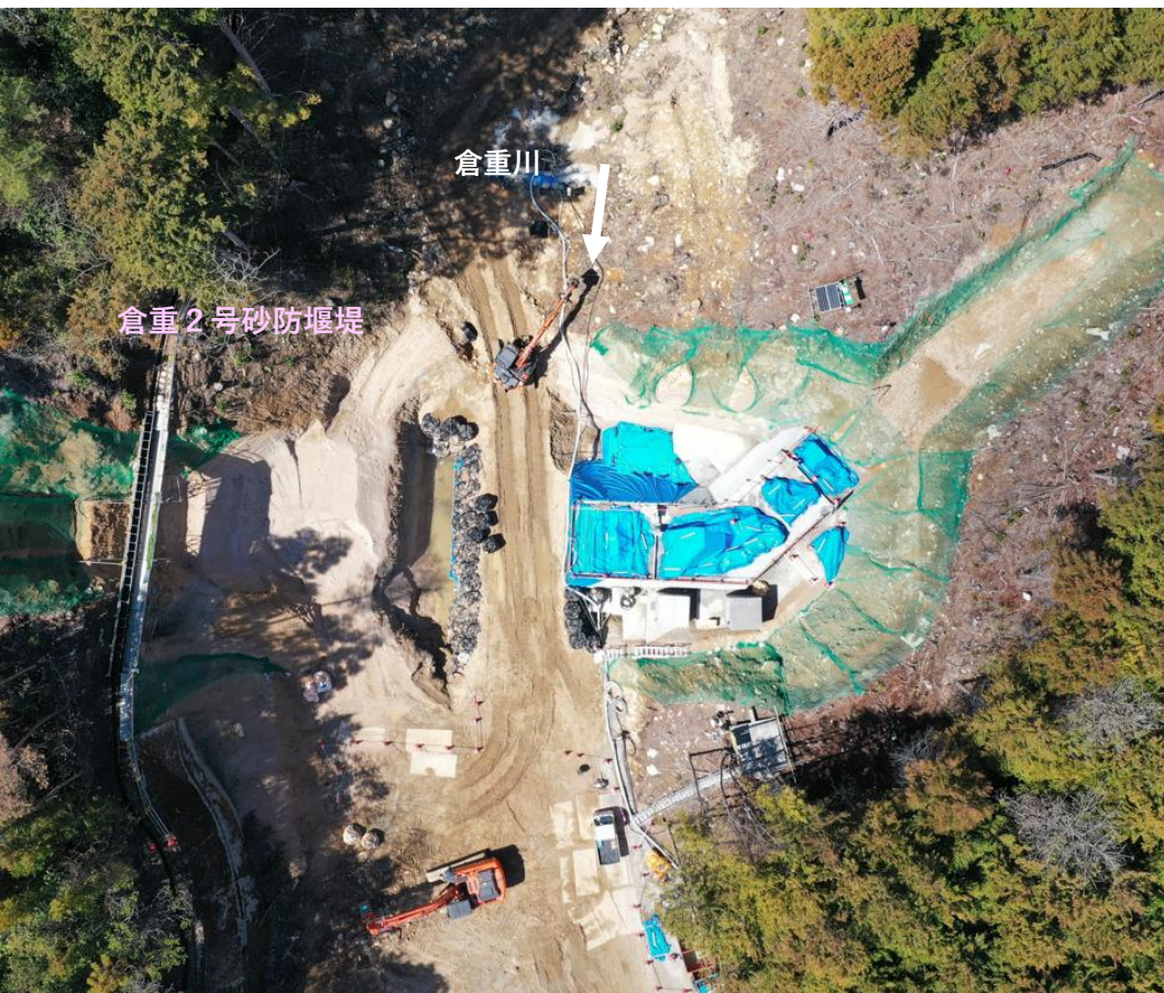
【全景 堰堤真上から】
