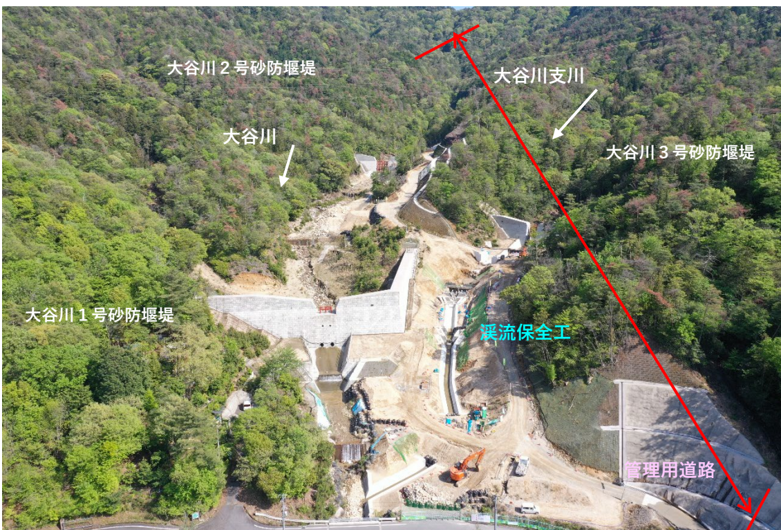
【施工状況①】
