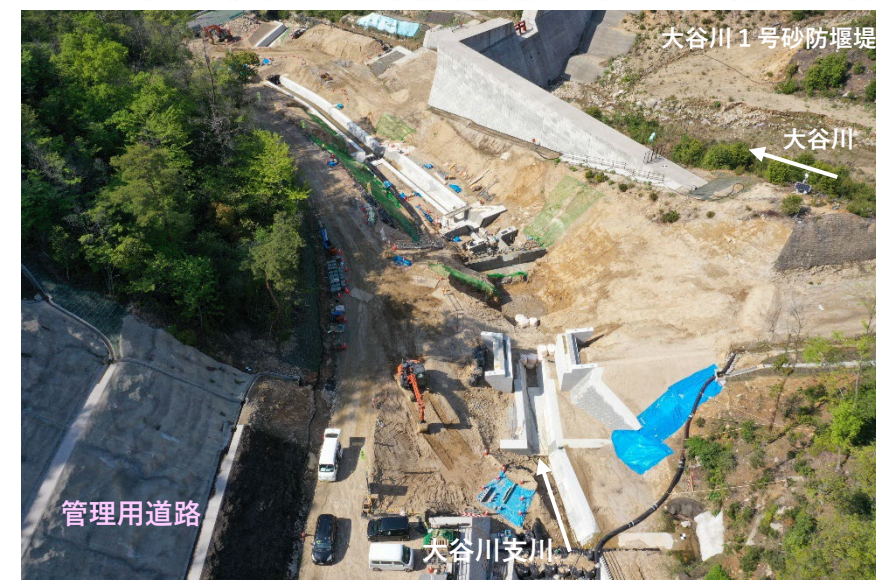
【施工状況②】
