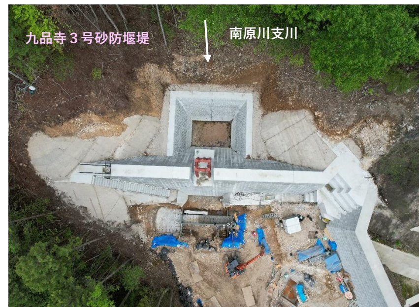
【砂防堰堤 堰堤上流側施工状況】
