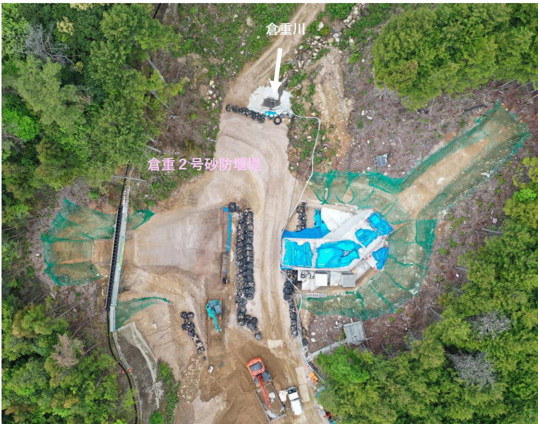
【全景 堰堤真上から】
