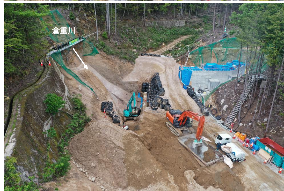
【施工状況（堰堤部施工状況）】
