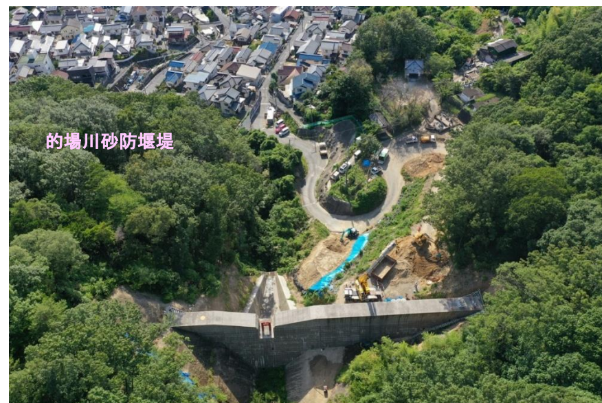
砂防堰堤全景（上流側より）
