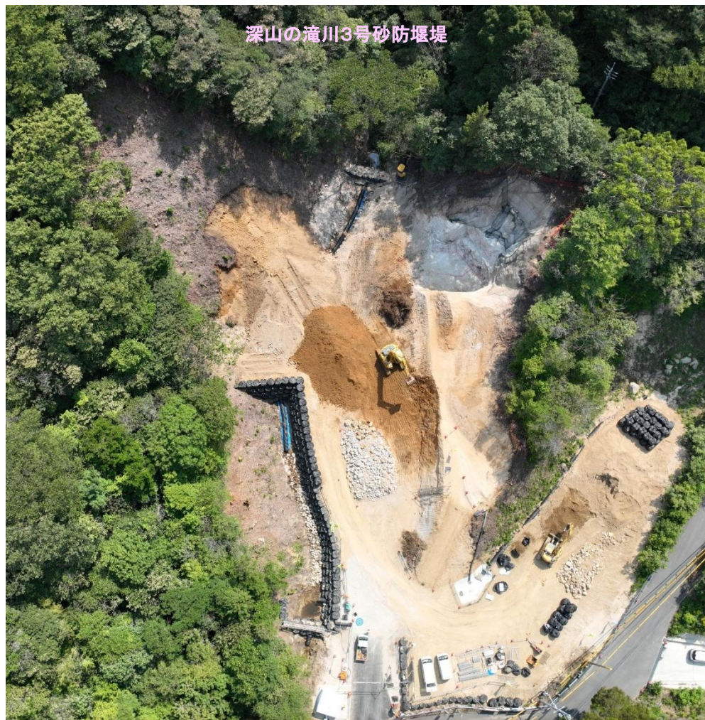
【施工状況（上空より）】
