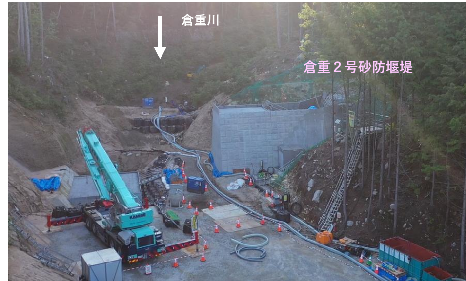
【施工状況（堰堤部施工状況）】
