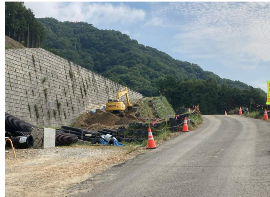
【施工状況（工事用道路撤去）】
