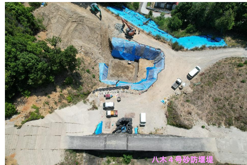
【 上空より 上流側から】
