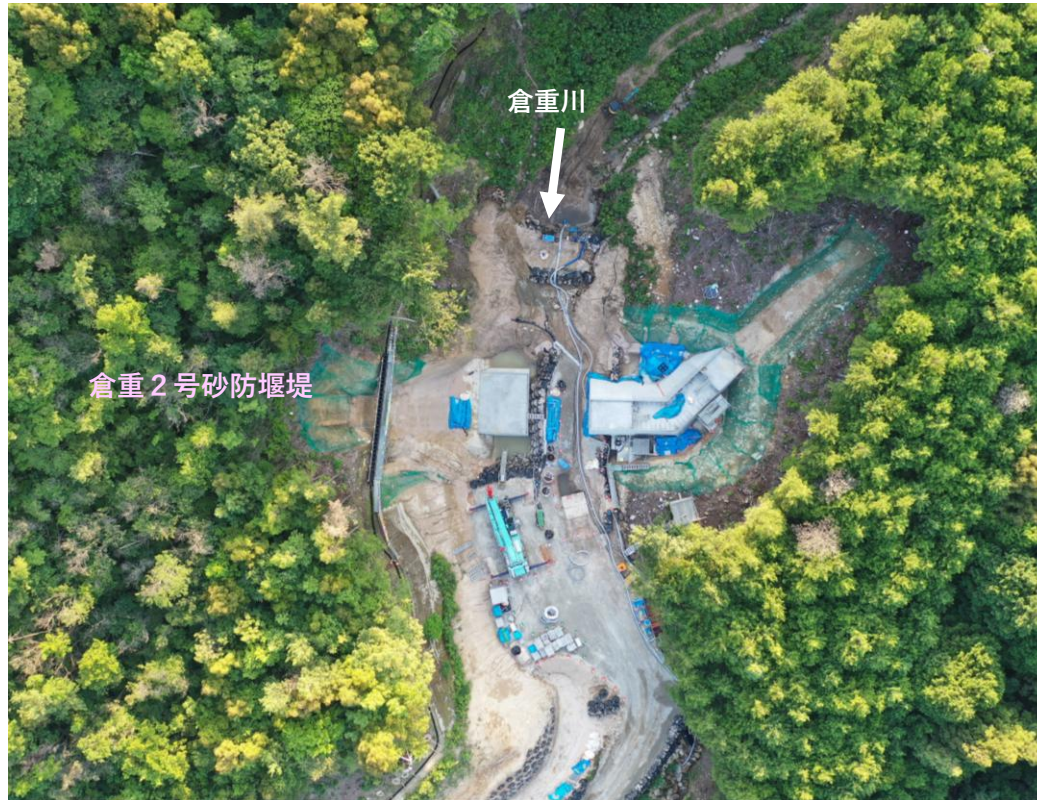
【全景 堰堤真上から】
