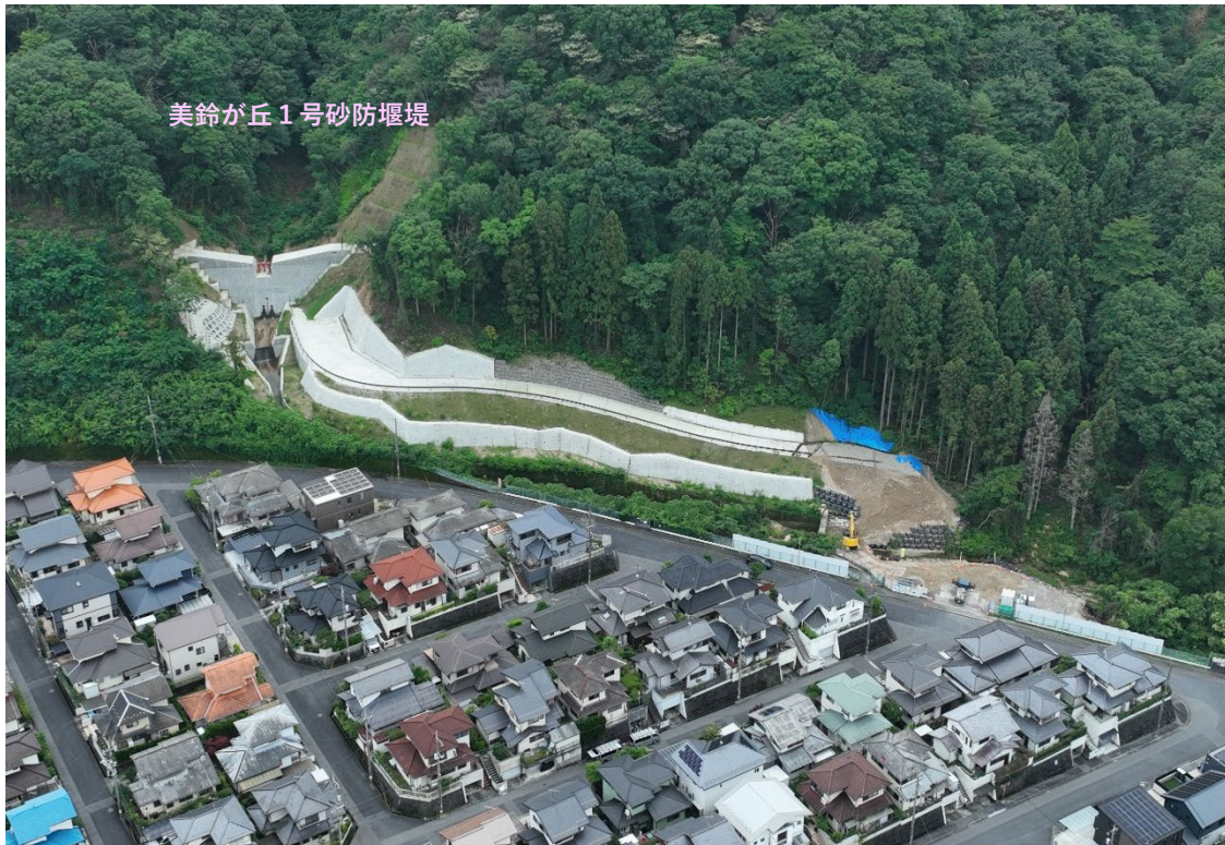
【美鈴ヶ丘1号砂防堰堤管理道 施工状況】
