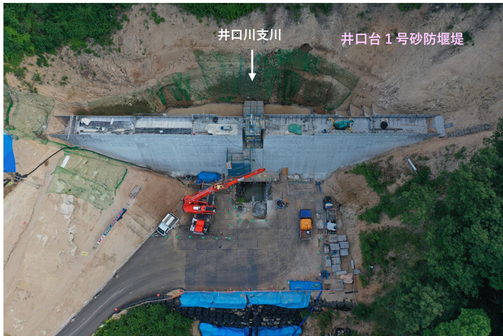
【上空より（堰堤下流から）】
