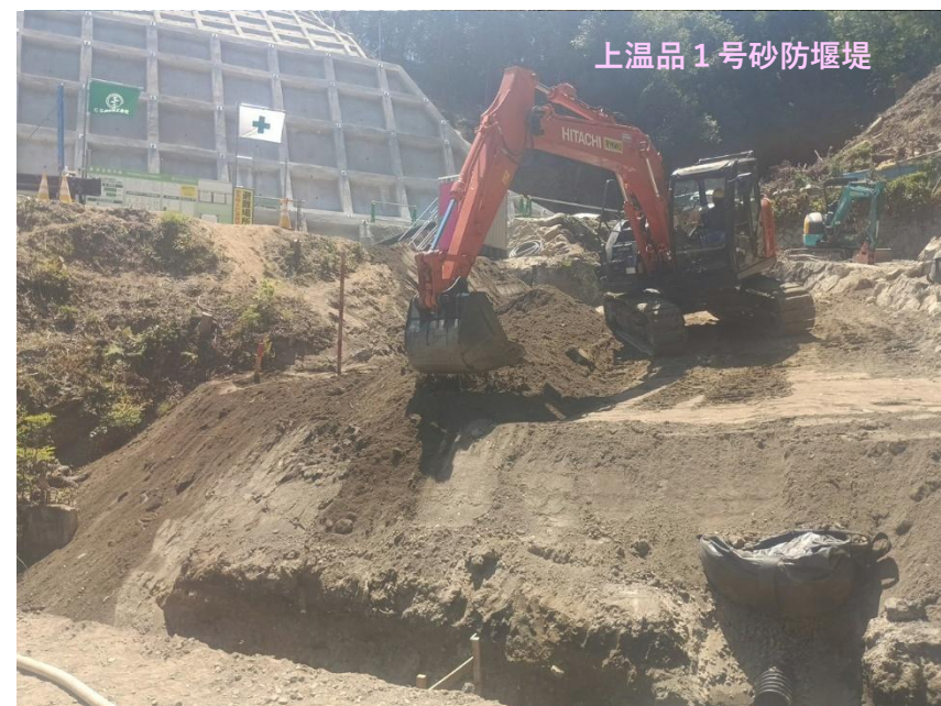
【回転場 施工状況】
