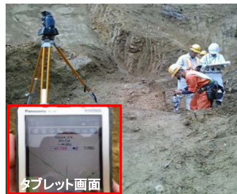
自動追尾型トータルステーション、 タブレットを使った日々の施工管理
