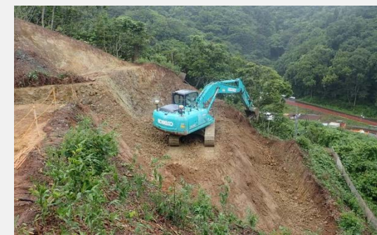
ICTによる作業土工状況(丁張レス)
