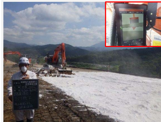
ICT活用による地盤改良工
