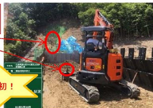
【ICT建機による本堤内部材敷均し】
