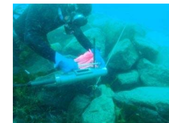
水中水準測量高さ管理
