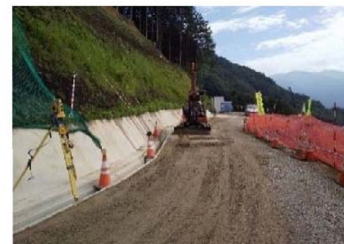
【ICT建機による路盤敷均し】
