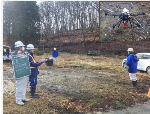
UAVレーザーによる起工測量
