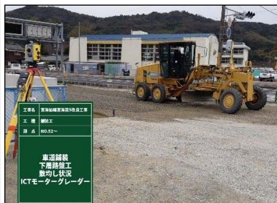
若手オペレーターによるICT路盤敷き均し作業
