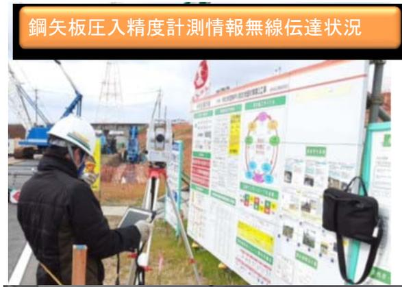
鋼矢板圧入精度計測情報無線伝達状況
