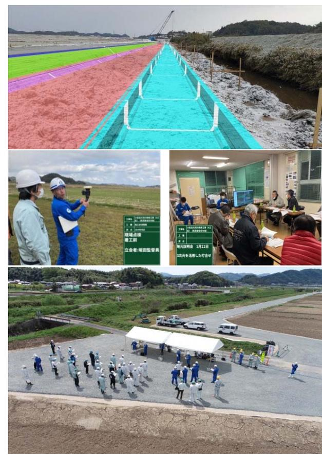
大型プレキャストU型水路設置が主たる工種である今回の工事において、水路の床掘をLight ICT施工にて行った。主に次のようなICT技術を積極的に採用することで、人件費削減、工程短縮、安全性向上、トラブルの事前回避等、「生産性と安全性の向上」を図ることが出来た。
