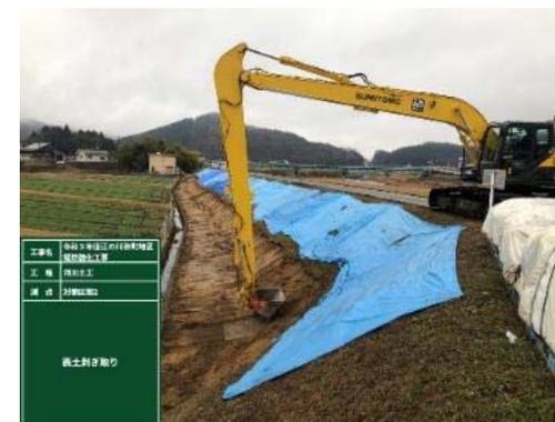
○作業半径が大きいロングアームBH(非ICT型建機)をMG化(マシンガイダンス)しICT施工を導入することで、工事用道路が不要となり工程短縮を図るとともに、操縦の難しいロングアームBHでも正確な施工を実施。
