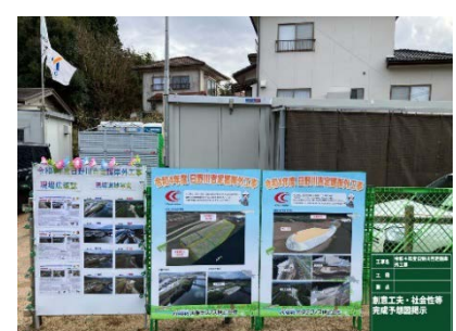
完成予想看板の設置
