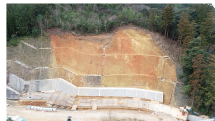
掘削・整形工完了
