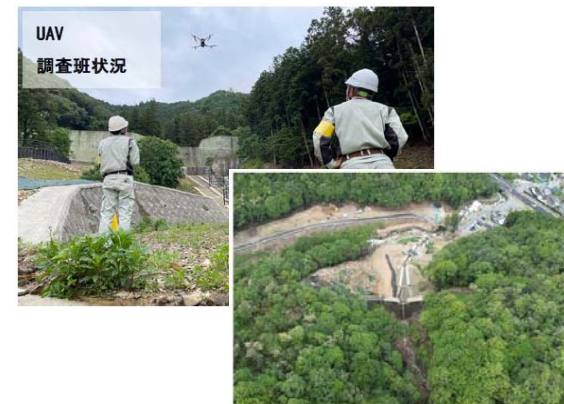
UAVを活用した溪流緊急概略点検
