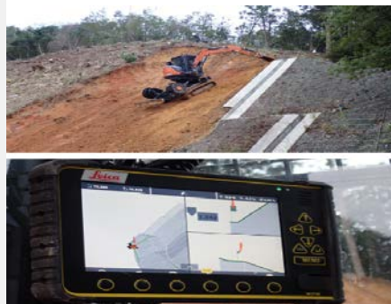
マシンガイダンスによる法面掘削
