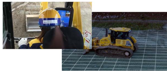
ICT建機による施工
