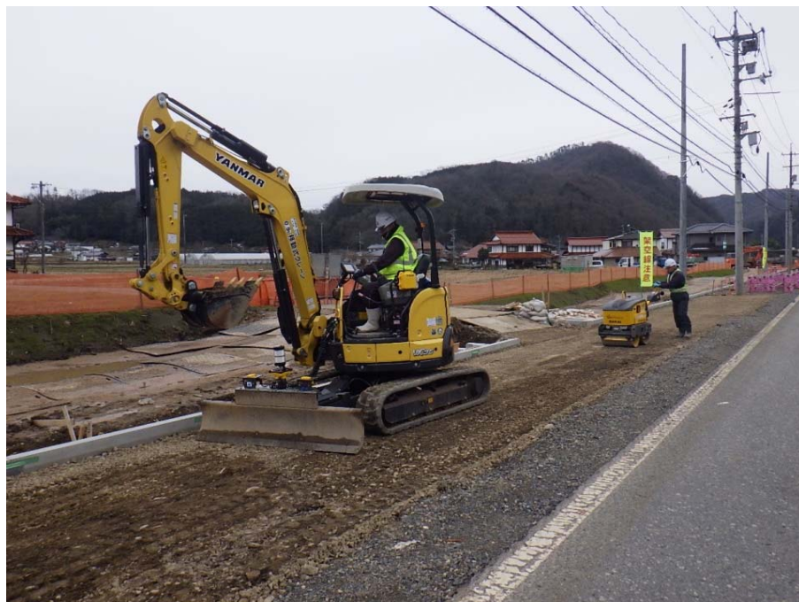
バックホウ 0.10m 3 級(3.5tクラス)
