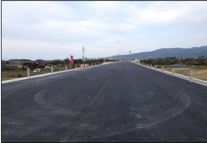
アスファルト舗装
