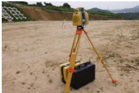
ICT建機による施工
