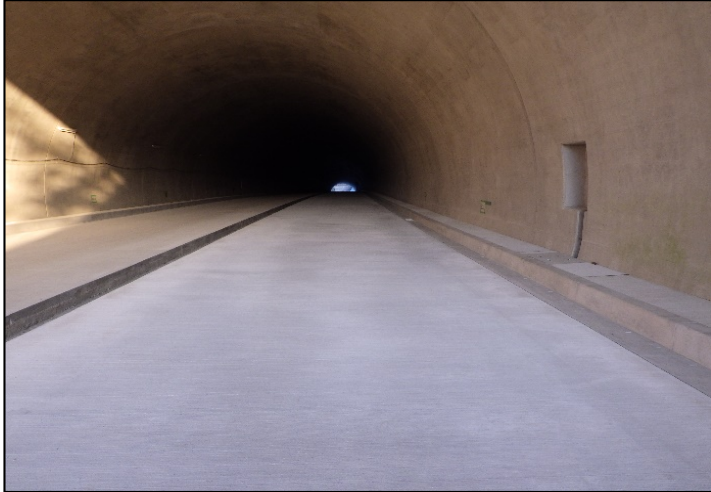
コンクリート舗装
