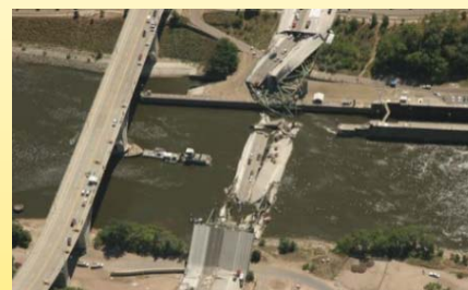
【ミシシッピ川に係る高速道路橋の落橋事故(2007年米ミネソタ州)】(出典: MN/DOT)
