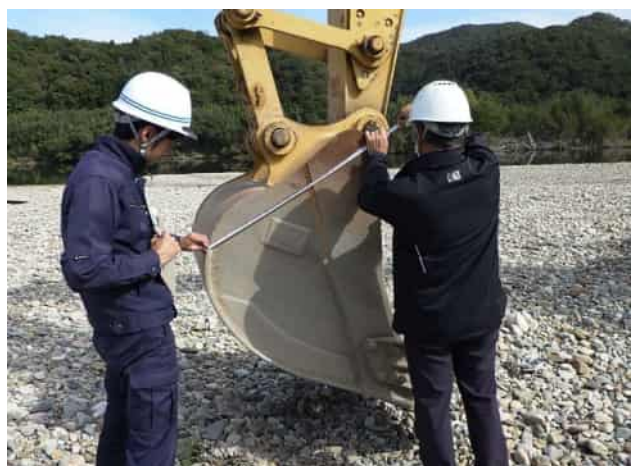
ICT建機精度確認試験実施状況
