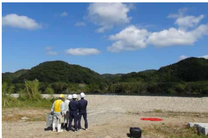
起工測量実施状況
