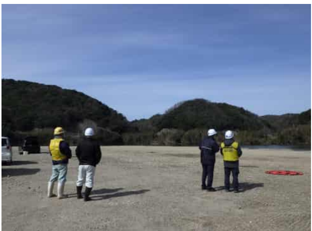
出来形測量実施状況
