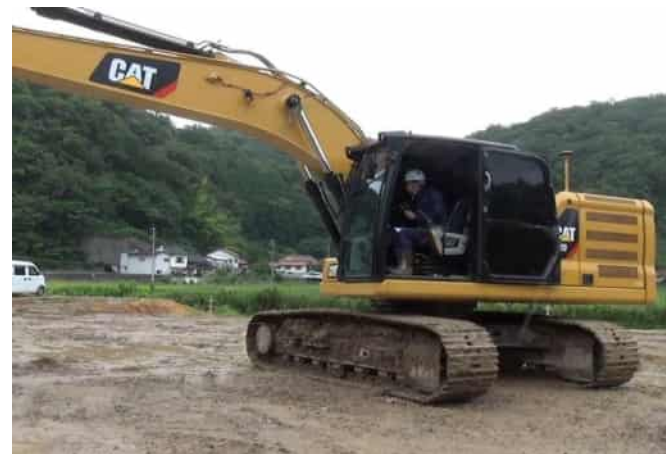
ICT建機のデータ設定
