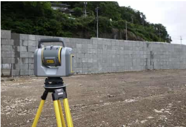
三次元出来形測量実施
