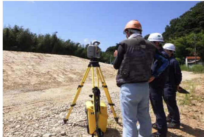
地上型レーザースキャナーによる3次元測量
