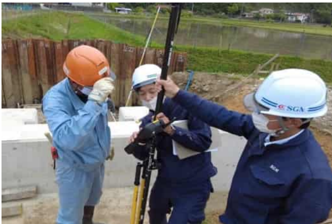
ICT施工前の現場調査(GNSS受信状況の確認等)
