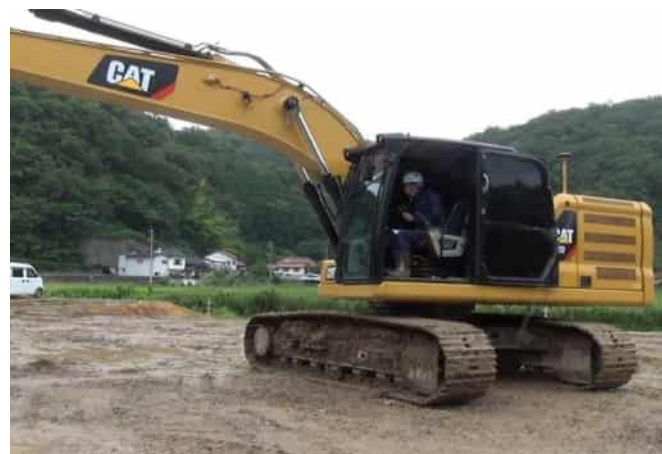
ICT建機のデータ設定
