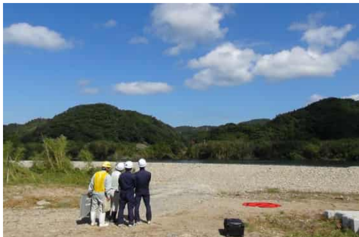
起工測量実施状況
